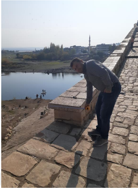
Şekil 2.17. Restore sonrası köprünün harpuşta duvarı
