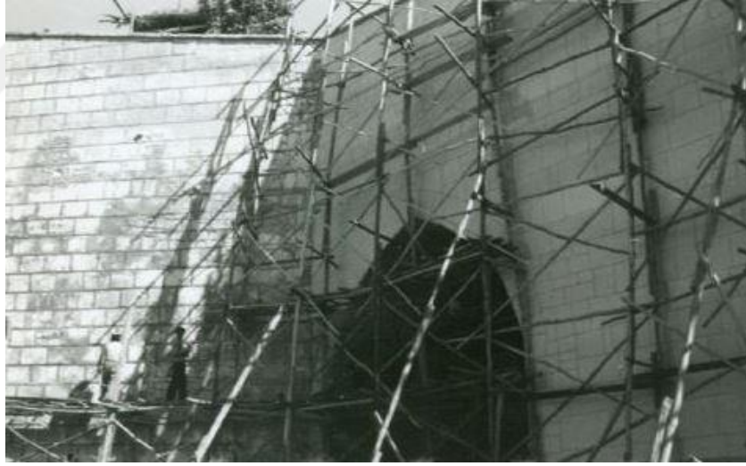
Şekil Ek 2.18. Malabadi Köprüsü mansap cephesi 1954 yılı onarım (KGM, 2009)
