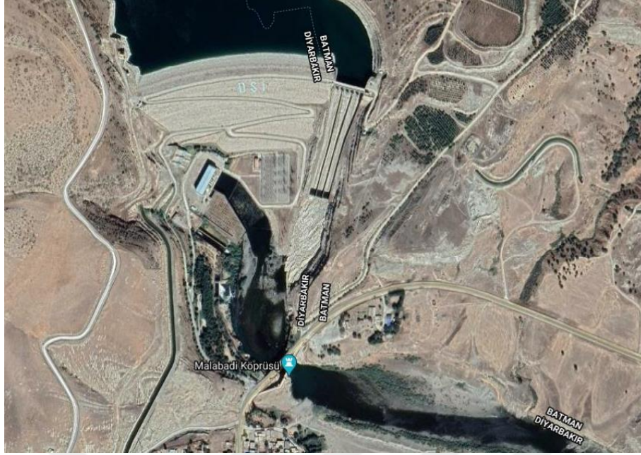
Şekil 2.2. Malabadi Köprüsü ve Batman barajı (parselsorgu.tkgm.gov.tr)
