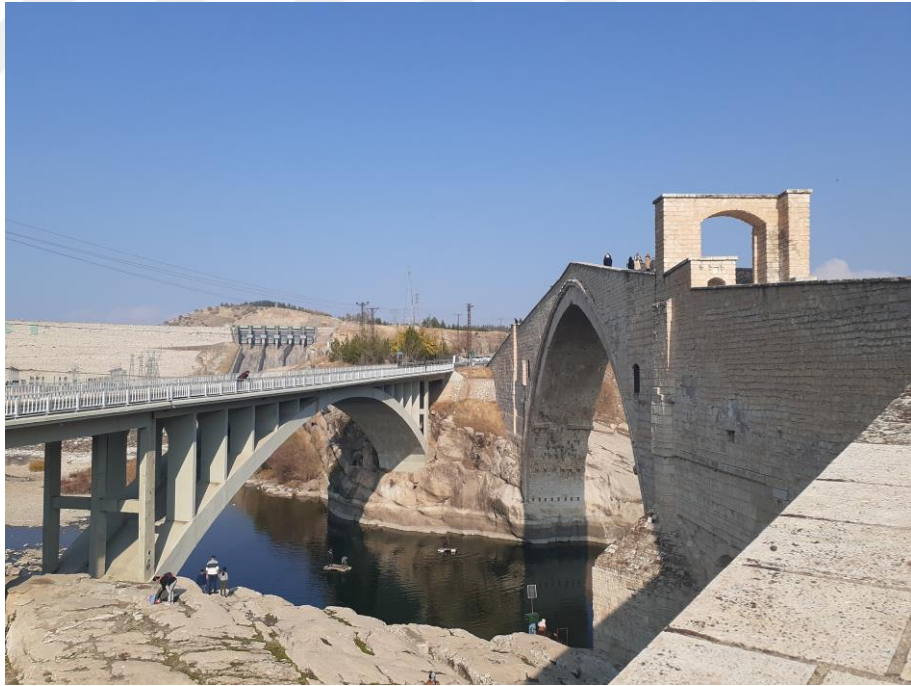
Şekil Ek 2.4. Malabadi Köprüsü ve hemen yanındaki betonarme köprü
