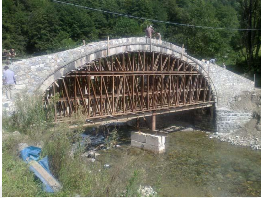
Şekil 2.7. Tarihi Orta Köy köprüsü kemer kalıbı çelik malzemeden
