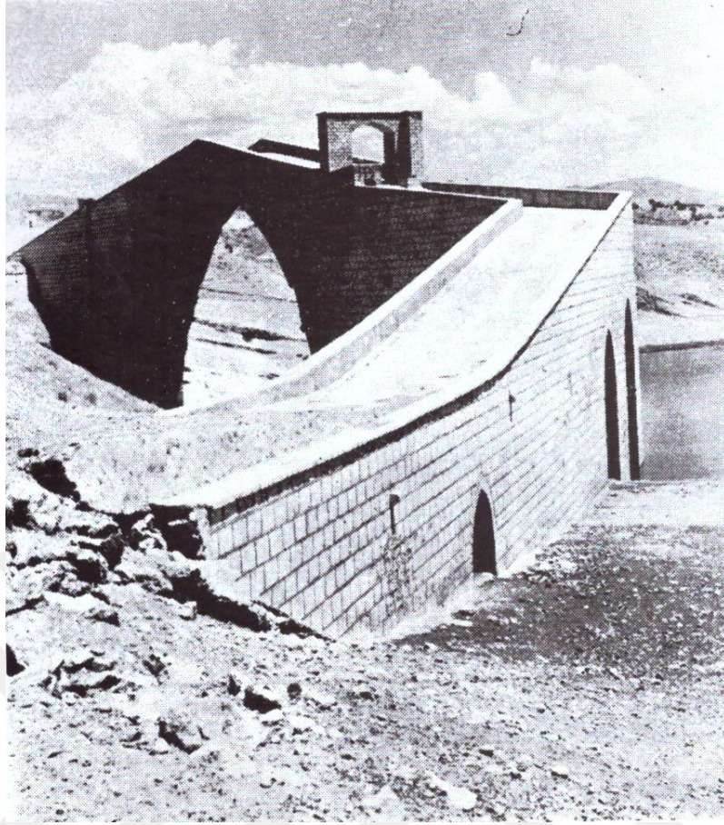
Şekil Ek 2.7. Malabadi Köprüsü memba cephesi (Çulpan, 2002)
