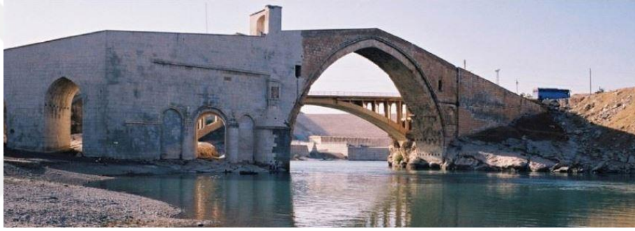
Şekil Ek 2.20. Köprüde 1985 yılında yapılan onarım (KGM, 2009)
