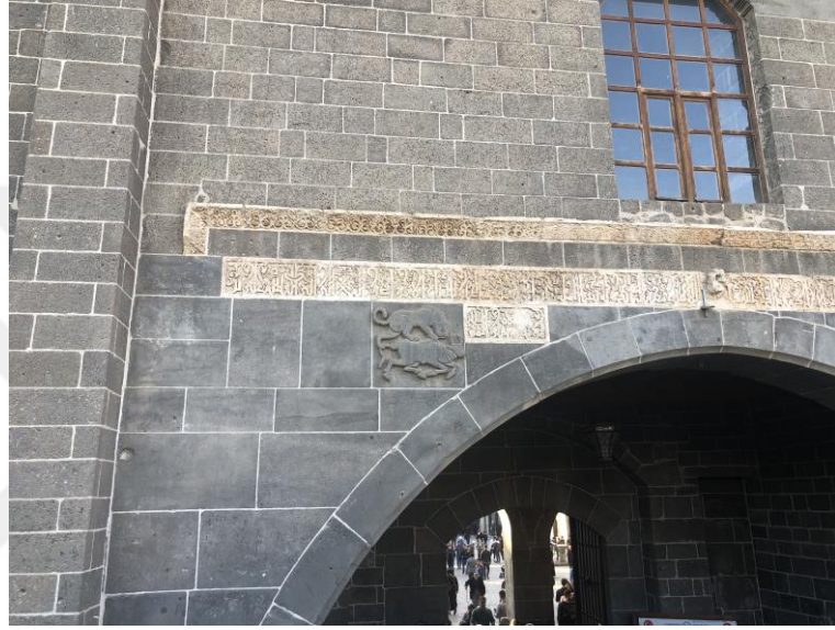
Şekil 2.14. Diyarbakır Ulucami cepheden görünüş (Mungan, 2020)
