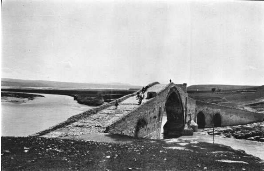
Şekil Ek 2.8. Malabadi Köprüsü 1952 yılı öncesine ait görüntü (KGM, 2009)
