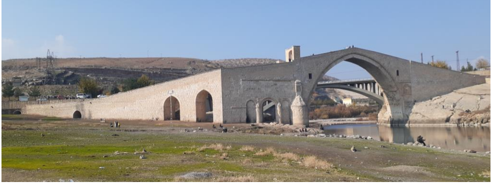
Şekil Ek 2.22. Restore sonrası köprünün mansap cephesi.
