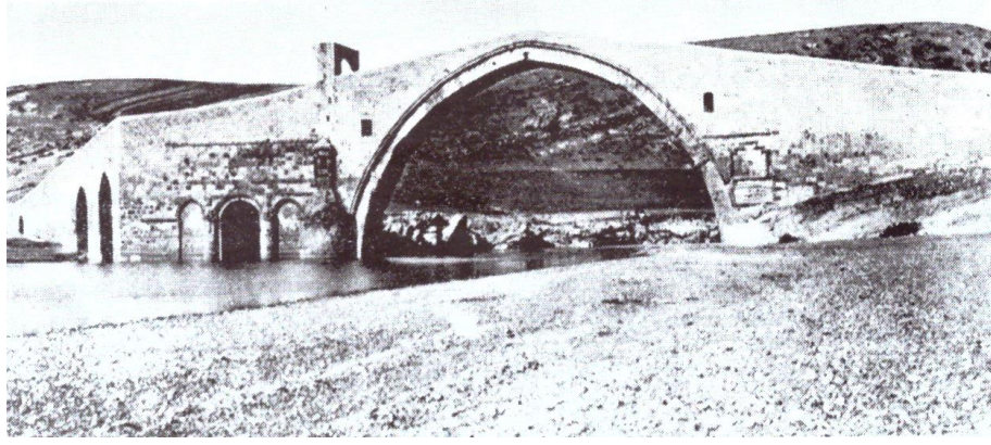
Şekil Ek 2.5. Malabadi Köprüsü memba cephesi (Çulpan, 2002)
