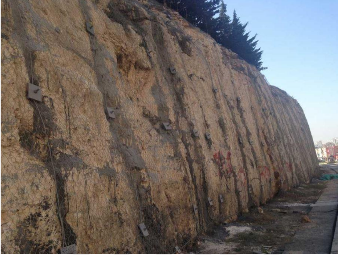
Şekil 8.16. Kaya kütleinin güçlendirilmesi için kaya bulonu uygulaması
