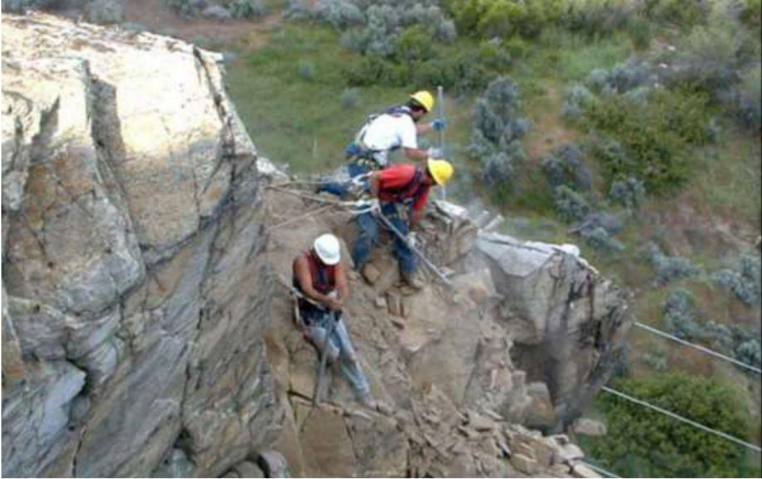
Şekil 8.15. Blok Temizliği (Maccaferri 2012)
