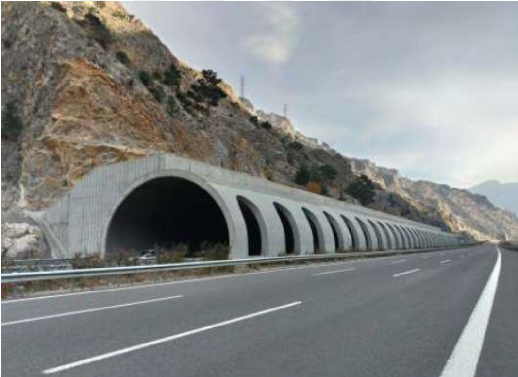
Şekil 8.25. Adana-Pozantı yolunda kaya düşmesi problemini bertaraf etmek için uygulanan aç-kapa/ koruma yapısına ait görsel (Akın, 2021).
