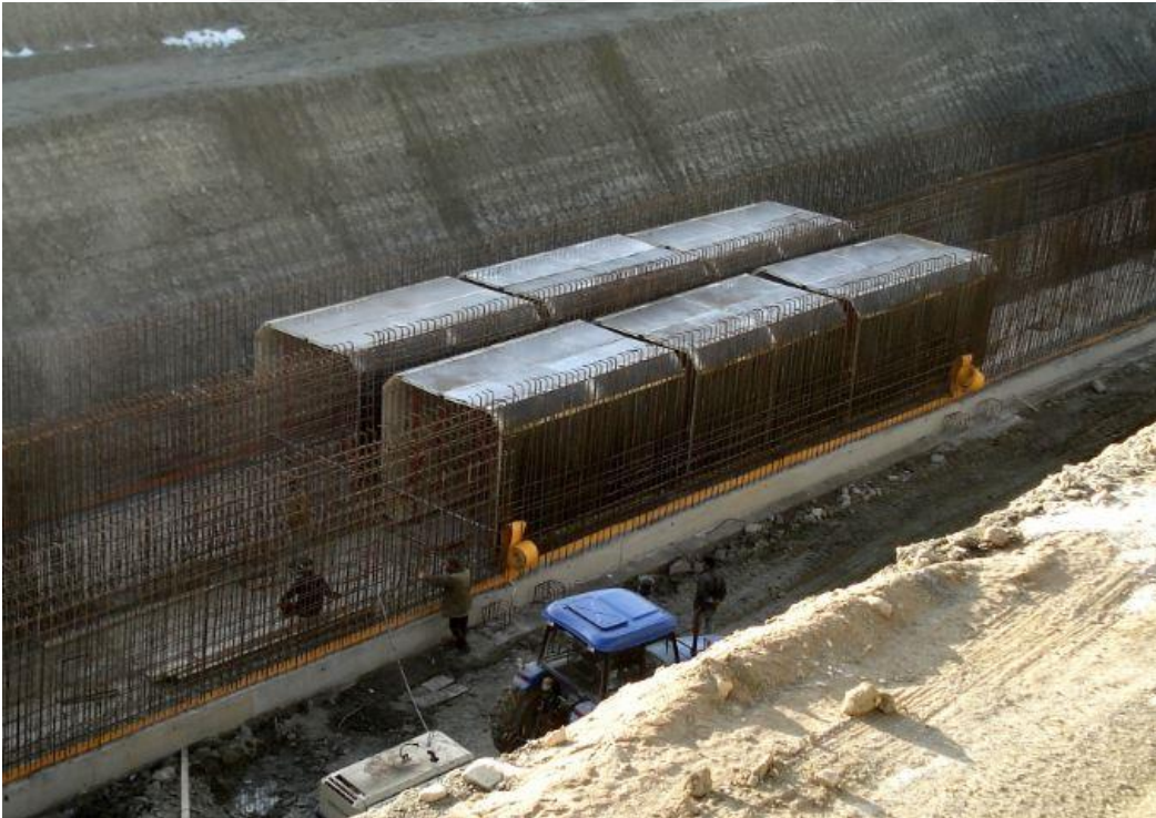
Şekil 8.21. Aç-Kapa yapısının yapım aşamasına ait görsel
