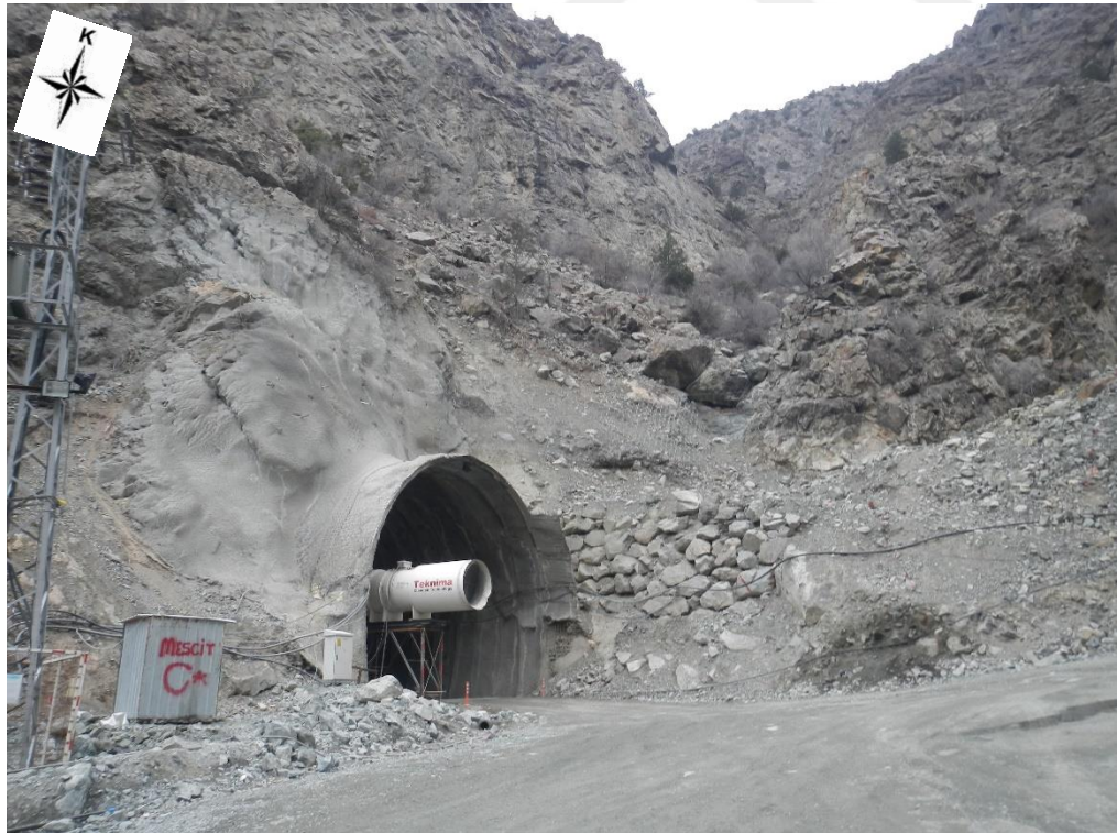
Şekil 2.2. Yamaç üzerine düşen serbest kaya blokları (X: 465 311, Y: 4 520 183 (TM42-ITRF96)).
