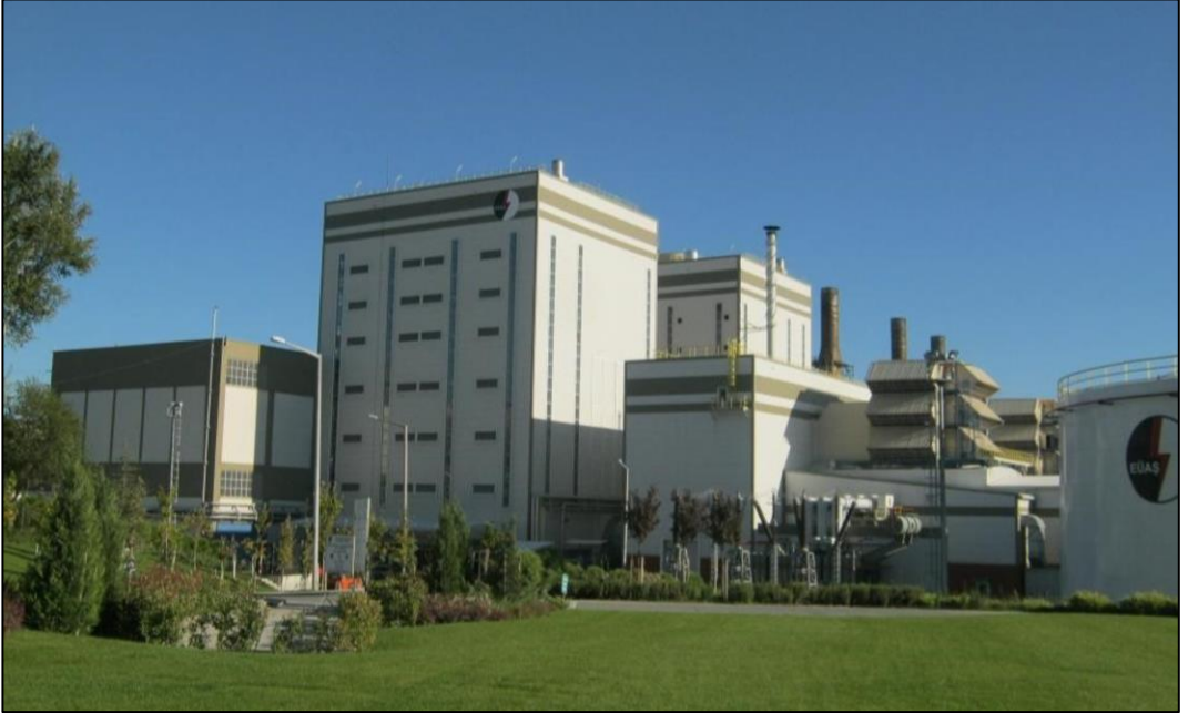
Şekil 4.11 Yeniden tam güçlendirme sonrası İstanbul Doğal Gaz Kombine Çevrim B Santrali'nin fotoğrafı
