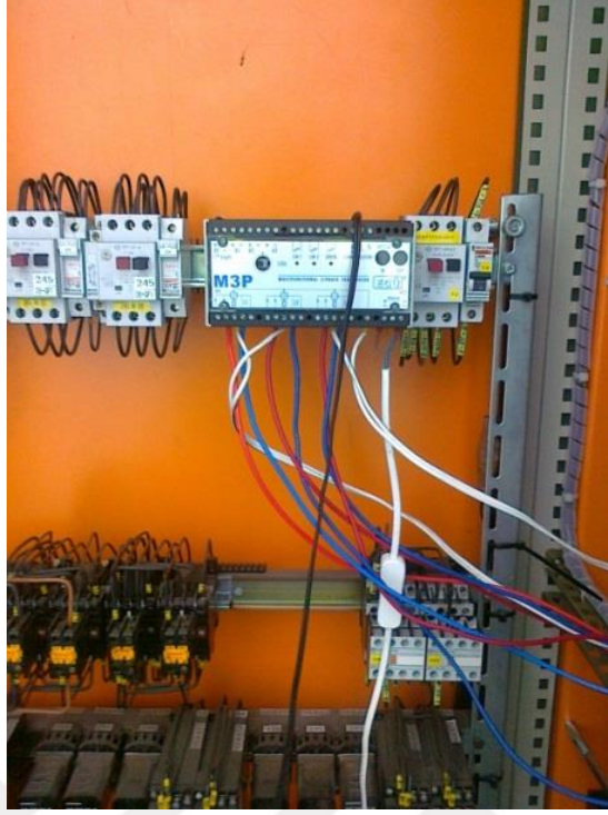
Şekil 3.7 Geçici olarak bağlantısı yapılmış bir EGÚ M3P güç analizörü
