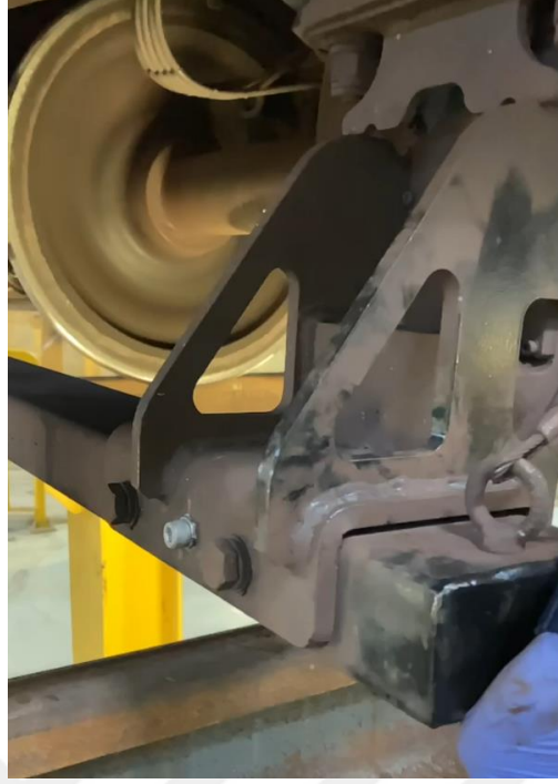
Şekil 5.4: Bağlantı Elemanı Gevşemesi Kaynaklı Sese Sebep Olan ODD Ekipmanı
