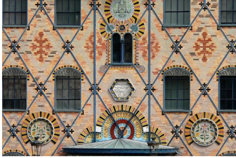
Şekil 8. Çelik iskeletli Menier Çikolata Fabrikası cephe detayı
