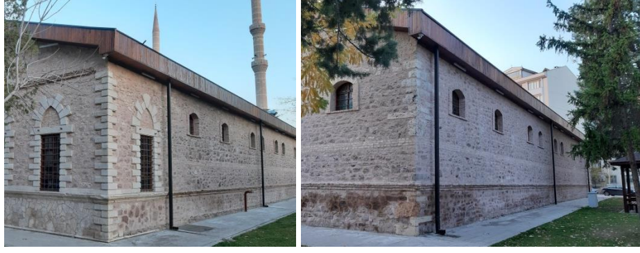
Şekil 65. Tantavi Ambarının kuzeybatı (solda) ve güneydoğu (sağda) cepheleri
