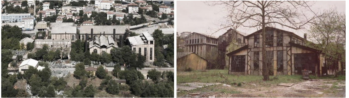
Şekil 45. İşlevini kaybetmesi sonucu atıl kalan Silahtarağa Elektrik Santrali
