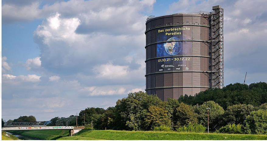
Şekil 41. Oberhausen Gazometresi görünüm
