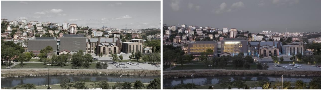
Şekil 55. Çağdaş Sanatlar Merkezi gündüz (solda) ve gece (sağda) görünümü
