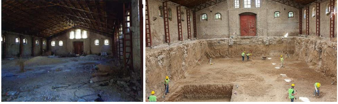
Şekil 66. Ambarının atıl durumdaki zemini (solda) ve müdahale aşaması(sağda)
