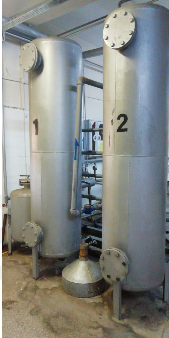
Şekil 2.4 Su Yumuşatma Sistemi Genel Görünümü (İbiş,2021)
