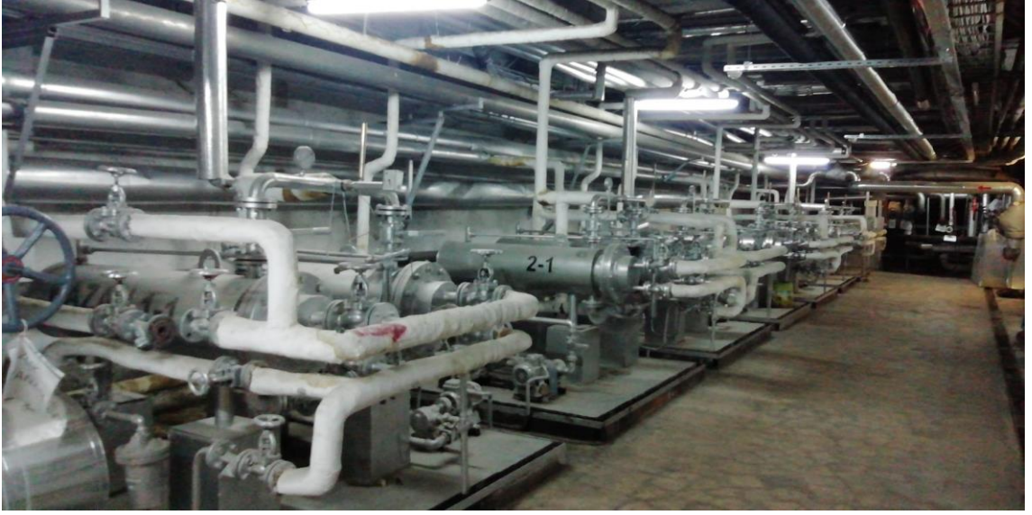
Şekil 2.13 Fuel-Oil Ring Hattı (İbiş,2021)
