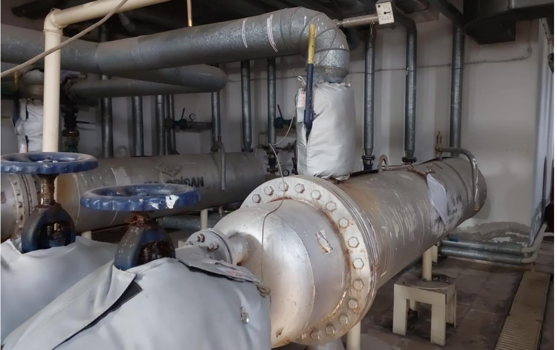
Şekil 2.11 Serpantinli Eşanjörün Genel Görüntüsü (İbiş,2021)
