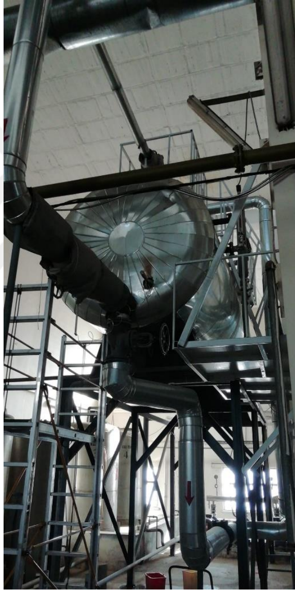
Şekil 2.5 Degazörün Genel Görünümü (İbiş,2021)
