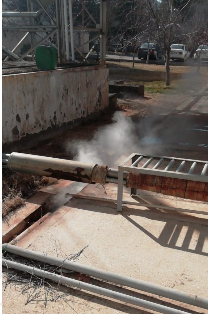
Şekil 2.6 Degazörden Atmosfere Tahliye Edilen Oksijen (İbiş,2021)
