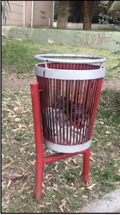
Şekil 4.145 Cumhuriyet Mahallesi: Cumhuriyet Pazaryeri Parkı-Çöp Kovası boyası dökülmüş, paslanma, sigara yanıkları
