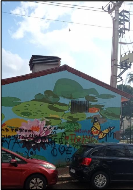
Şekil 4.96 Bostanlı Mahallesi: Cemal Bağcı Parkı-Trafo Binası Grafiti
