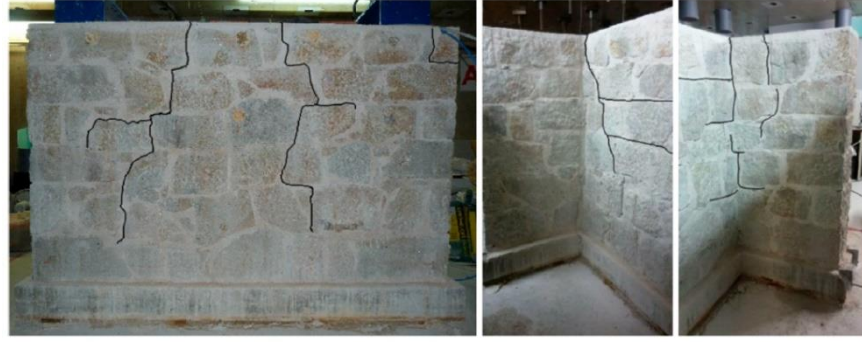
Şekil 3.37. Deney sonrası IRG duvarda meydana gelen çatlaklar
