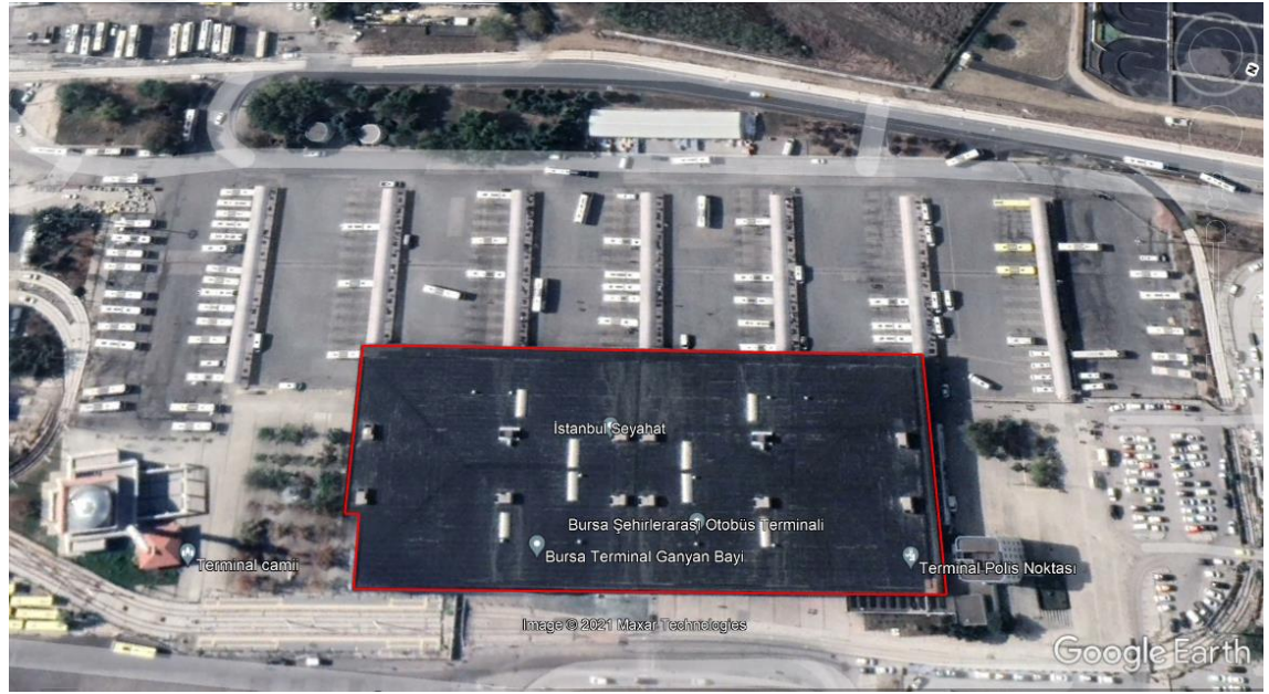
Şekil 3.3. Bursa otogarının kapalı alanı.
