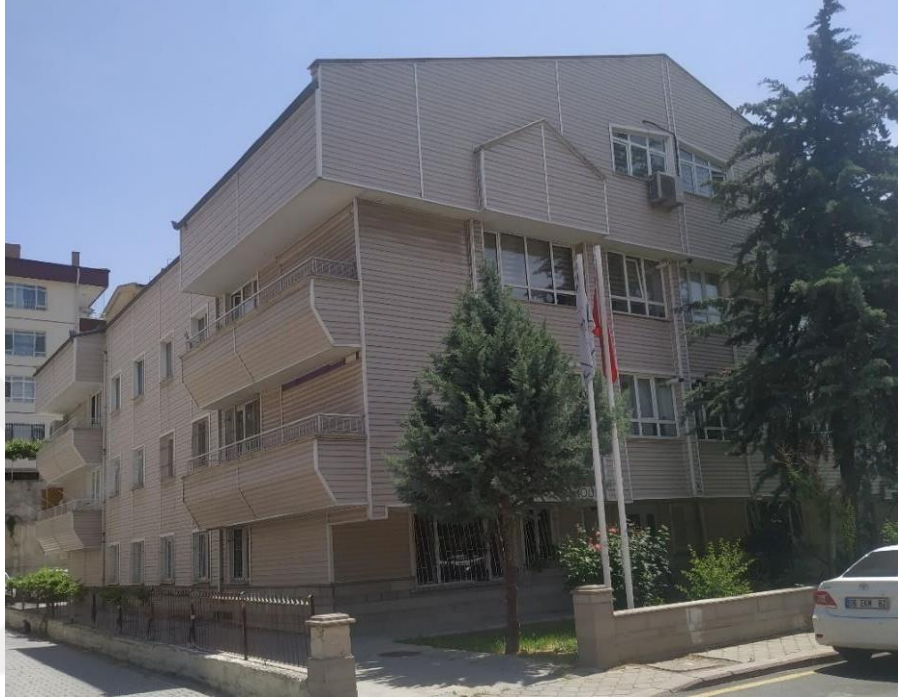
Şekil 2.5. Betonarme binalarda ağır çıkma örneği
