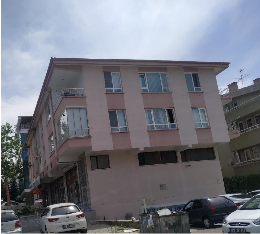
Şekil 2.7. Betonarme binalarda kısa kolon örneği
