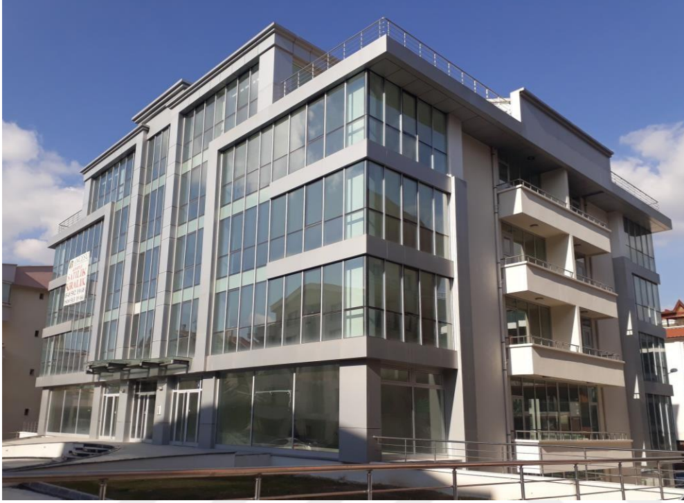
Şekil 2.9. Görünen yapı kalitesinin iyi olduğu betonarme bina örneği
