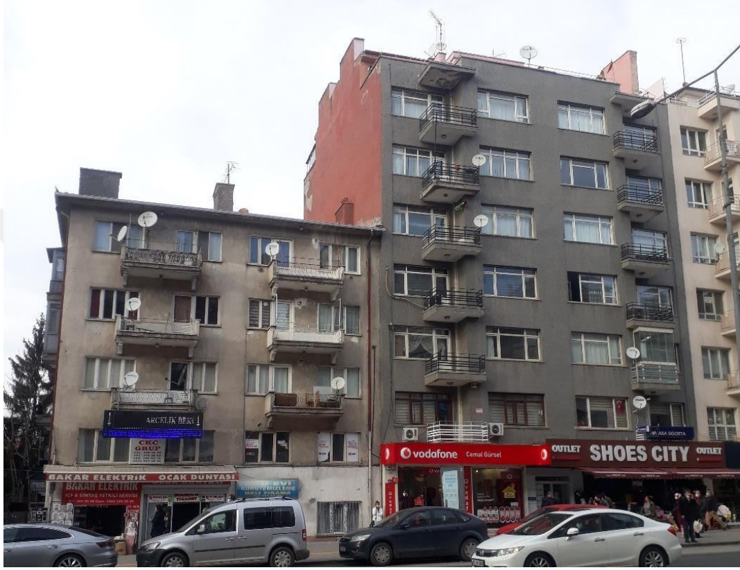
Şekil 2.13. Bitişik nizam yapılarında çarpışma etkisi örneği
