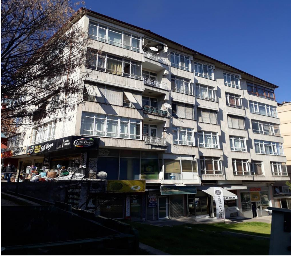
Şekil 2.1. 6 Katlı betonarme bina örneği
