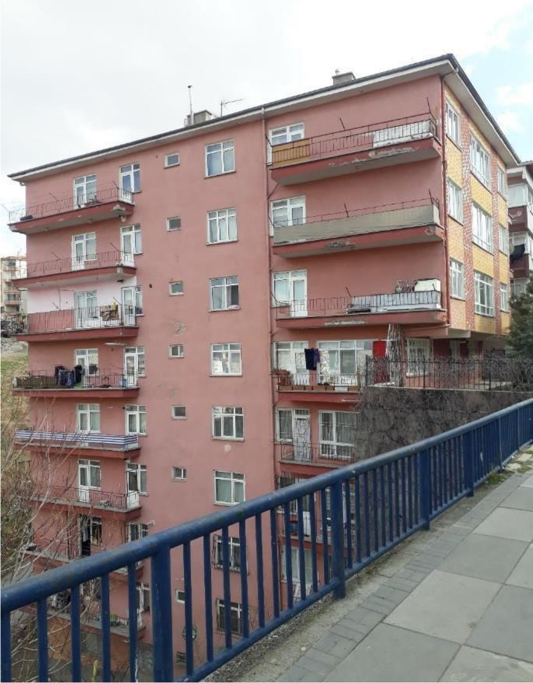
Şekil 2.16. Betonarme binalarda topoğrafik etki örneği
