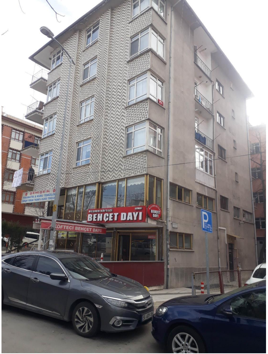
Şekil 2.8. Betonarme binalarda kısa kolon örneği
