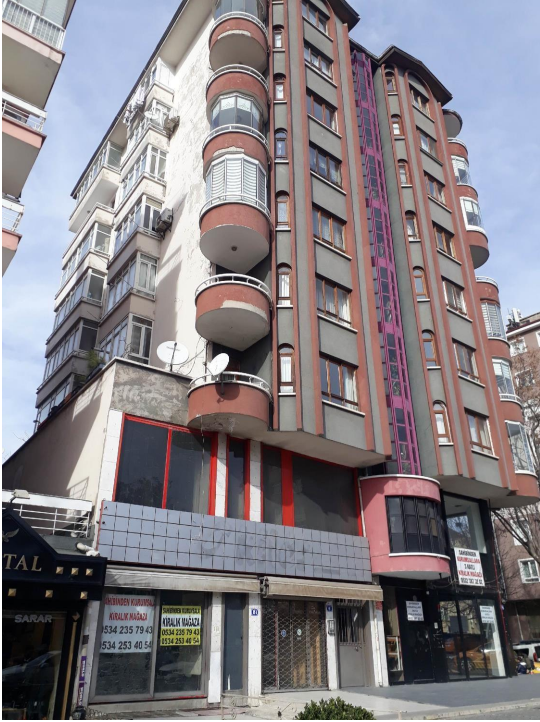
Şekil 2.4. Betonarme binalarda yumuşak kat örneği
