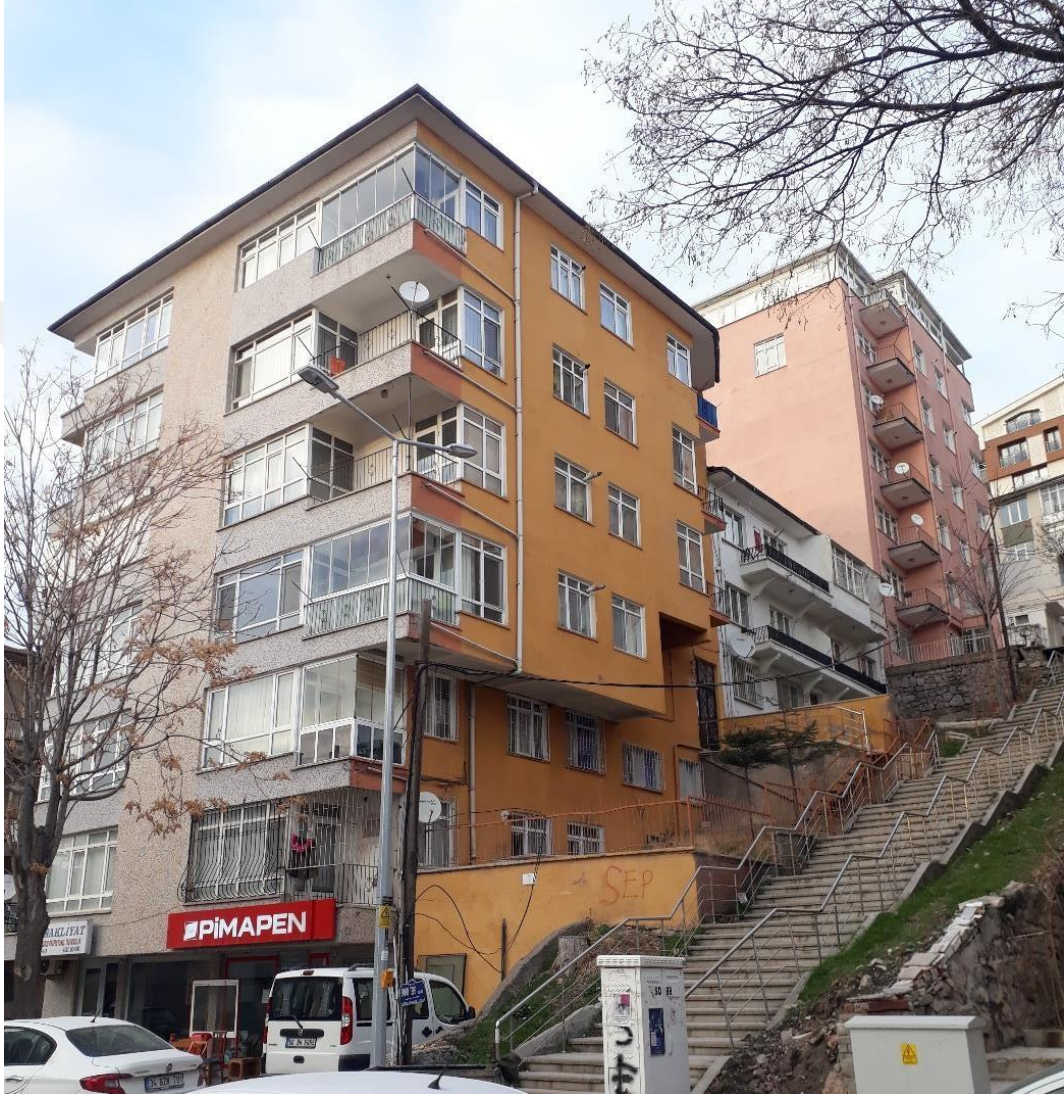
řekil 2.15. Betonarme binalarda topođrafik etki rneđi
