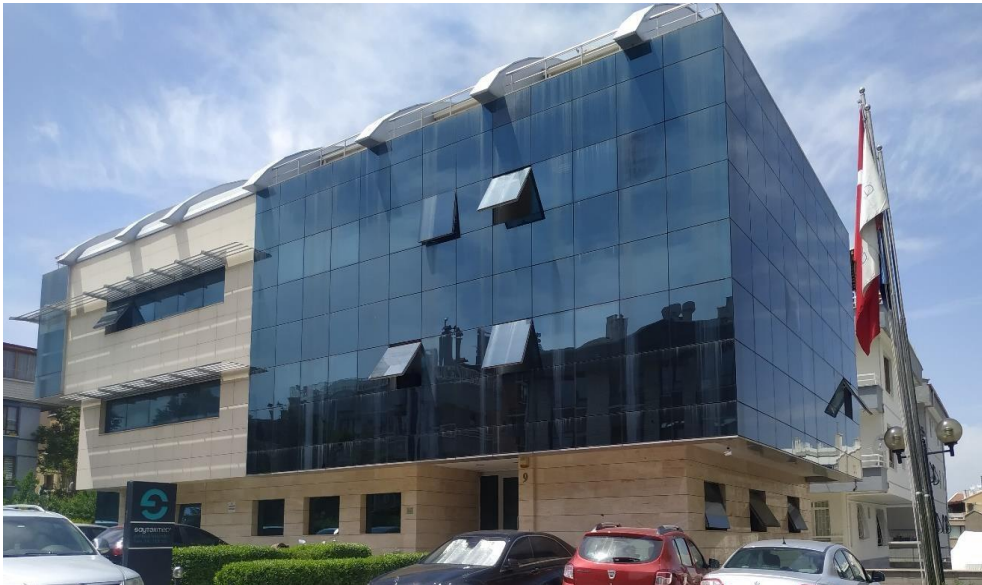
Şekil 2.10. Görünen yapı kalitesinin iyi olduğu betonarme bina örneği
