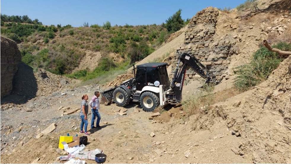
Şekil 3.5. Kepçe (back-hoe) yardımı ile arazide numune alım aşaması.
