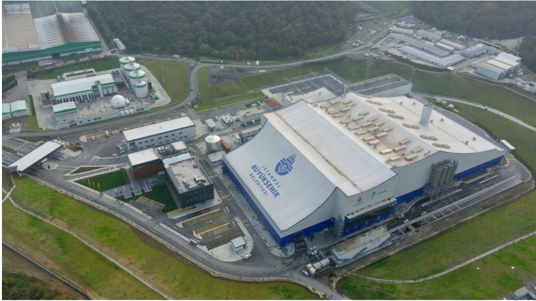
Şekil 3.11: İBB Atık Yakma ve Enerji Üretim Tesisi (İ.B.B Proje sunumu, 2021)
