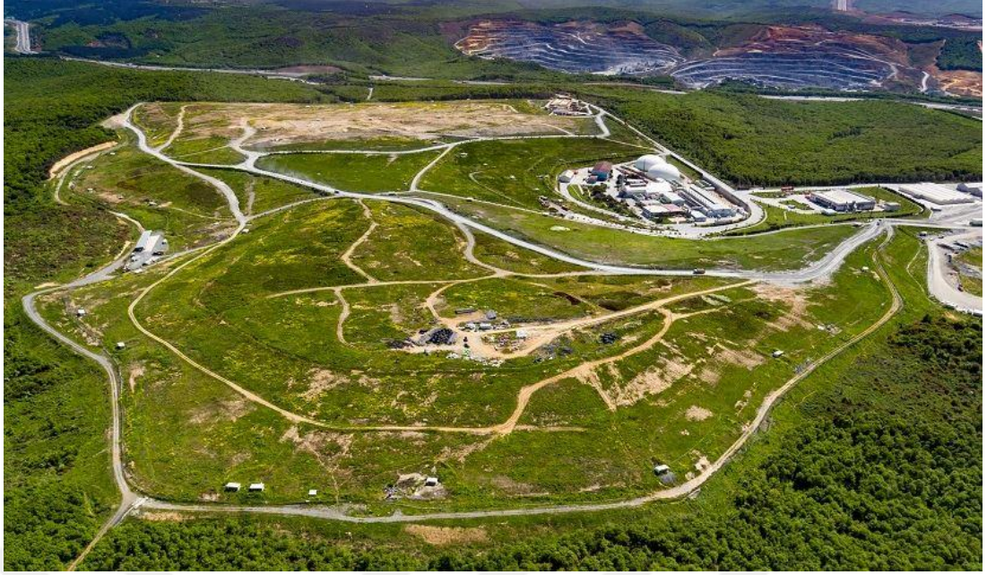
Şekil 2.7: Kemerburgaz Düzenli Depolama Sahası ve Enerji Üretim Tesisi (İSTAÇ, 2021)
