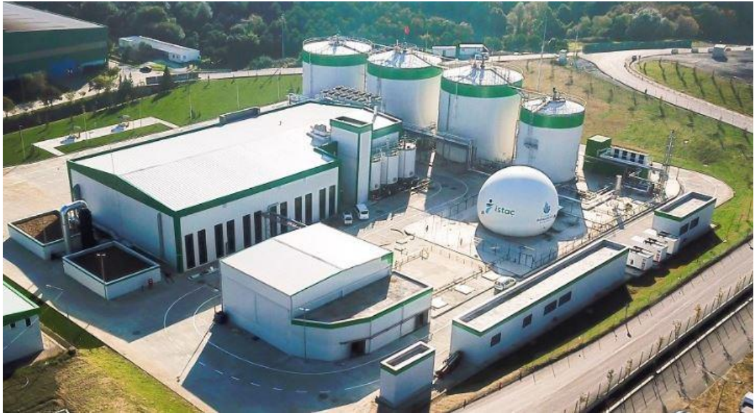
Şekil 2.9: İBB Eyüp Kemerburgaz Biyometanizasyon Tesisi (İSTAÇ, 2021)
