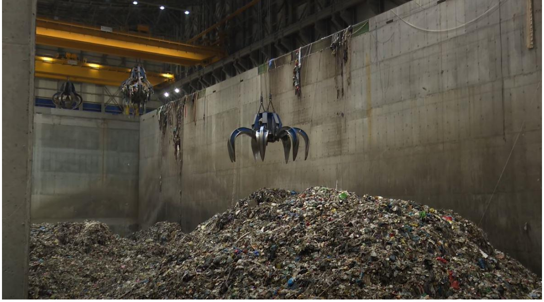
Şekil 3.14: Atık Depolama Haznesi ve Vinç Örneği
