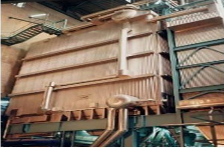
Şekil 3.17: Buhar Kazanı Örneği
