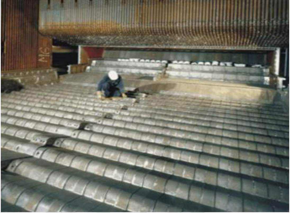
Şekil 3.16: Atık Yakma Fırını ve Hareketli Izgara Örneği
