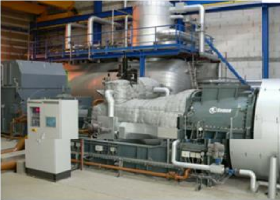
Şekil 3.18: Türbin Jeneratör Örneği
