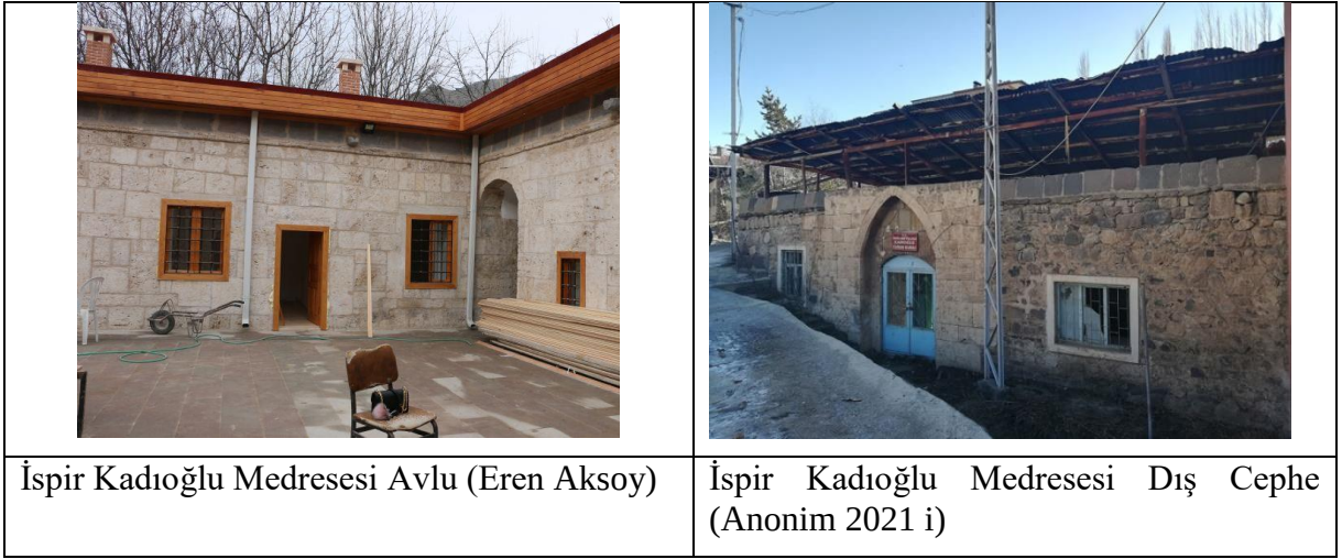
Şekil 14. Avlu ve Dış Cephe Farklı Malzeme Uygulaması
