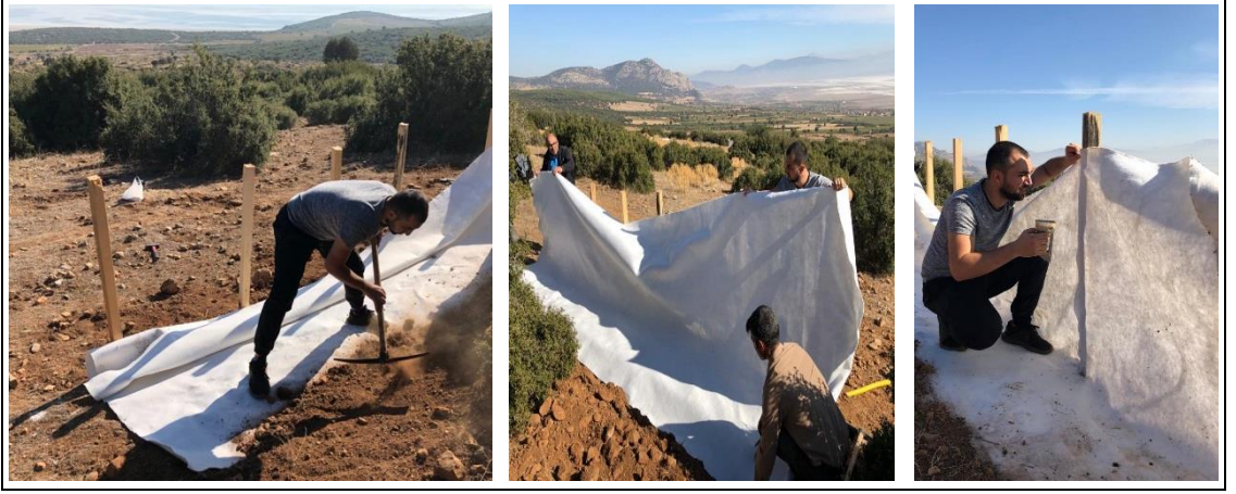
Şekil 3.8. Model havzalara geotekstil parcel kurulumu
