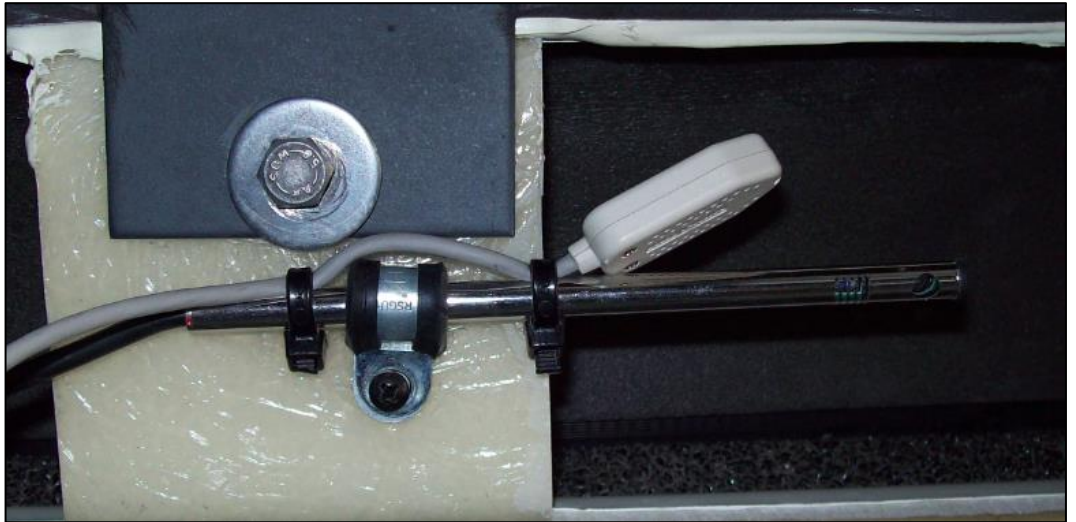
Şekil 3.46. Bağıl nem ve hava hızı sensörü montajı
