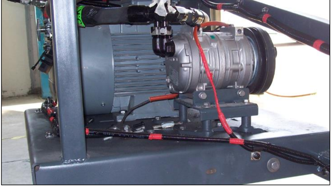
Şekil 3.41. Klima kompresörü montajı
