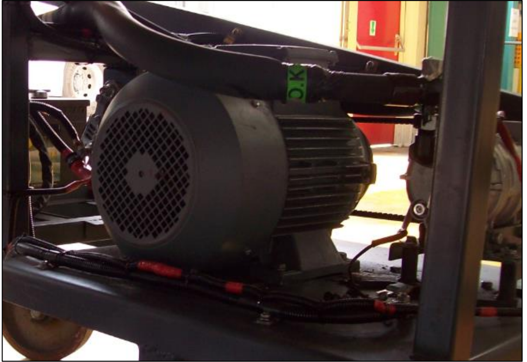
Şekil 3.42. Elektrik motoru montajı
