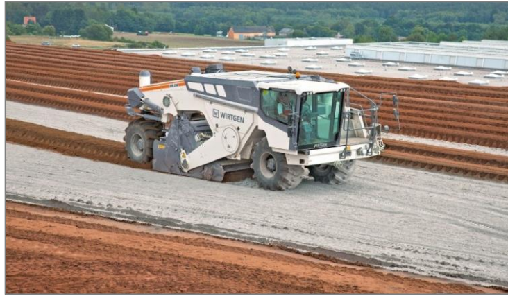
Fotoğraf 4.2. Kireç ile zemin stabilizasyonu (Anonim, Kasım 2021)
