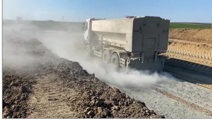
Fotoğraf 4.1. Çimento ile yol dolgusu stabilizasyonu (Anonim, Ekim 2021)
