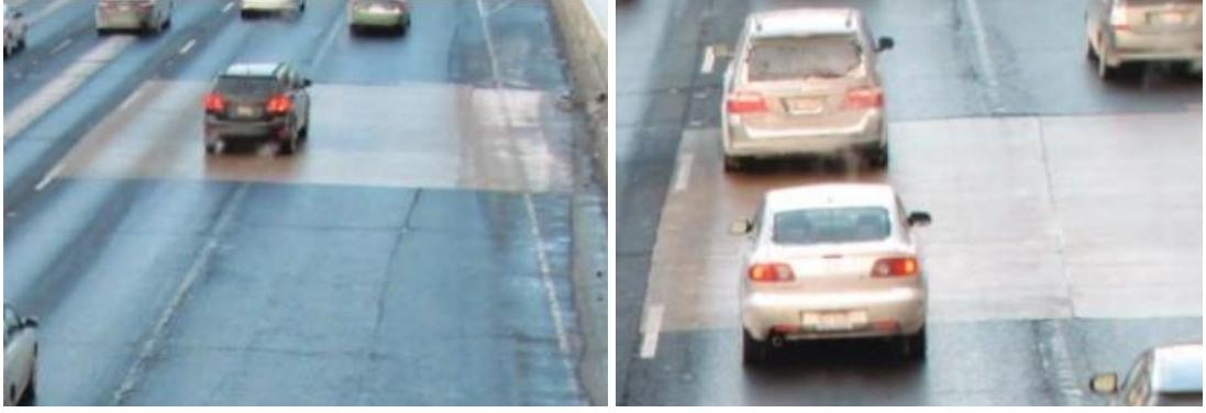
Şekil 1.1 KAC'ın tamir ve onarım malzemesi olarak kullanımı (Burris, Kurtis ve Morton, 2015)
