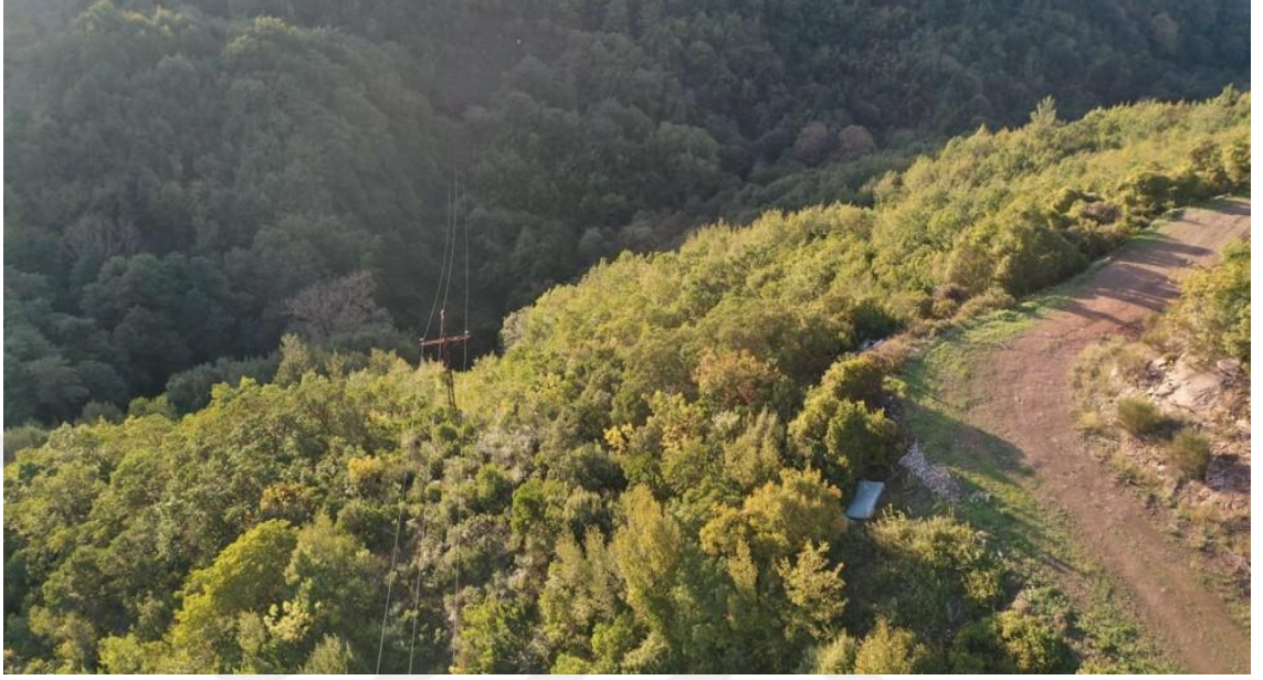
Őekil 2.3 36 kV ve daha az enerji nakil hattı
