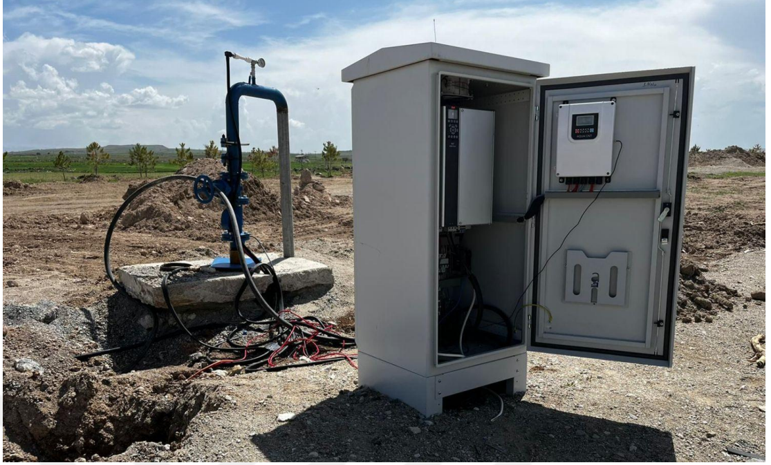
Şekil 3.5 Sahada derin kuyu dalgıç pompa testi (Acıgöl Belediyesi, Nevşehir, 2022)
