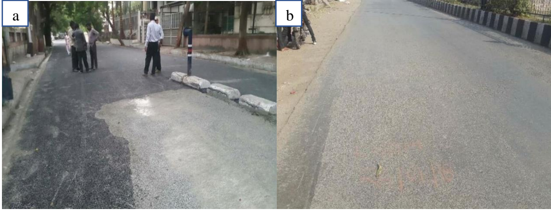
Şekil 2.2. a) AÇH'nin PA yüzeyine dökülmesi; b) Tamamlanmış YRK yüzeyi
