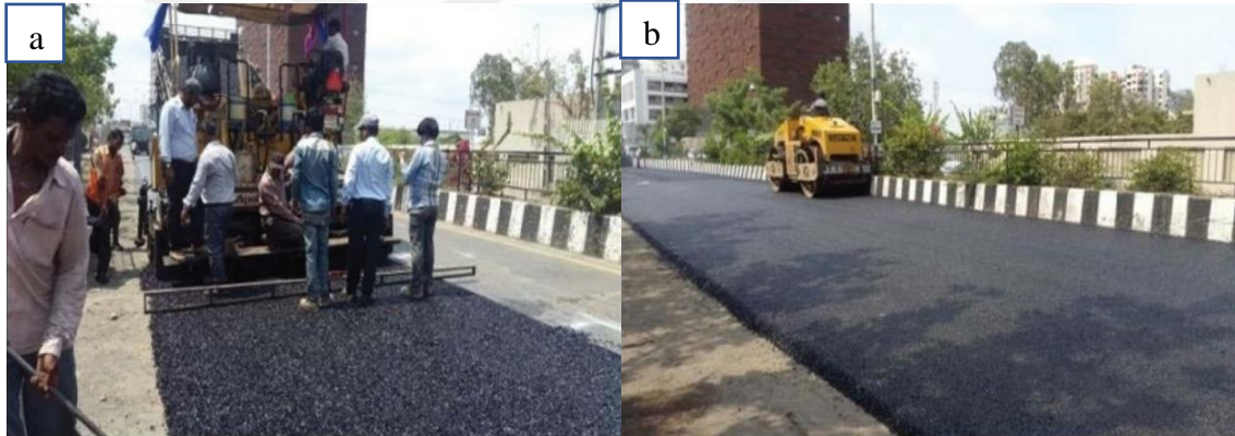
Şekil 2.1. PA imalat adımları, a) PA'nın finişer ile serilmesi; b) PA'nın silindir ile sıkıştırılması
