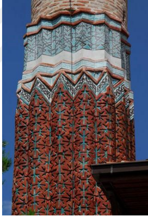
Resim 1: Konya Sahip Ata Camii, minare, sırlı tuğla
