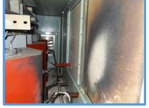
Şekil 2.18 Trafolarla meydana gelen hasar
