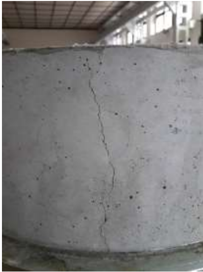
Resim 3.16. Kısıtlanmış rötre deneyi sonucu numunede oluşan çatlak ve çatlağın mikroskop görüntüsü
