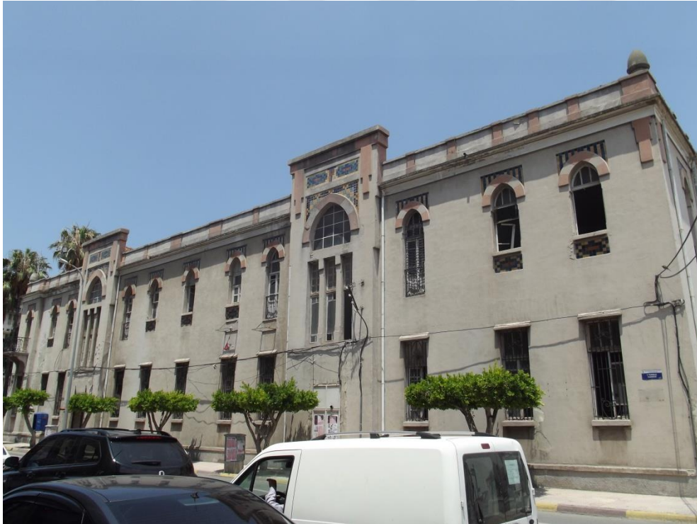
Fotoğraf 5.5.2.5. İskenderun Adliye Binası, Güney Cephesi, 2016
