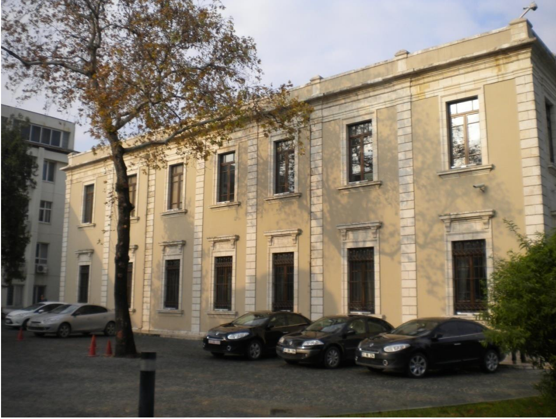
Fotoğraf 5.1.5.2. Hatay Valilik Binası, Güneydoğu Cephesi, 2016
