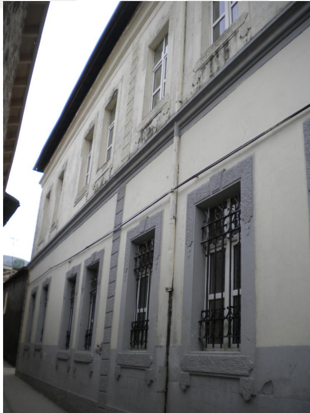
Fotoğraf 5.2.3.3. Antakya Frerler Okulu, Kuzey Cephesi, 2016
