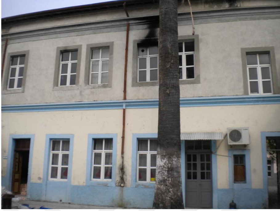
Fotoğraf 5.2.3.4. Antakya Frerler Okulu, Güney Cephesi, 2016
