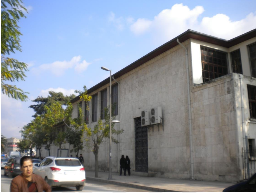
Fotoğraf 5.5.3.2. Antakya Müzesi, Batı Cephesi, 2016
