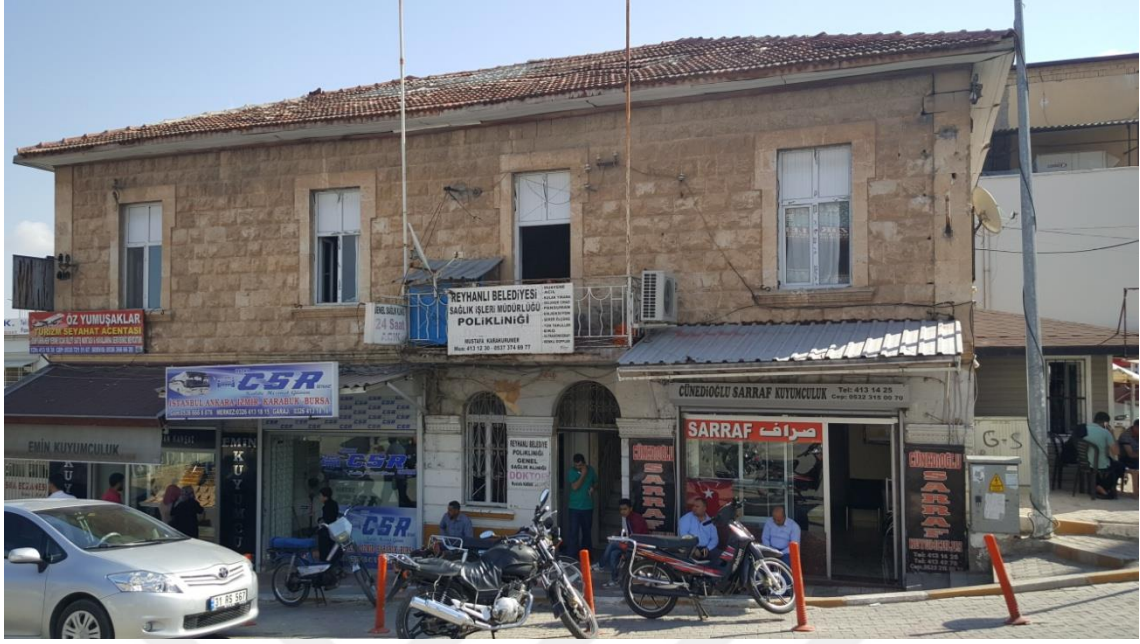
Fotoğraf 5.1.4.1. Reyhanlı Belediye Binası, Batı Cephesi, 2016
