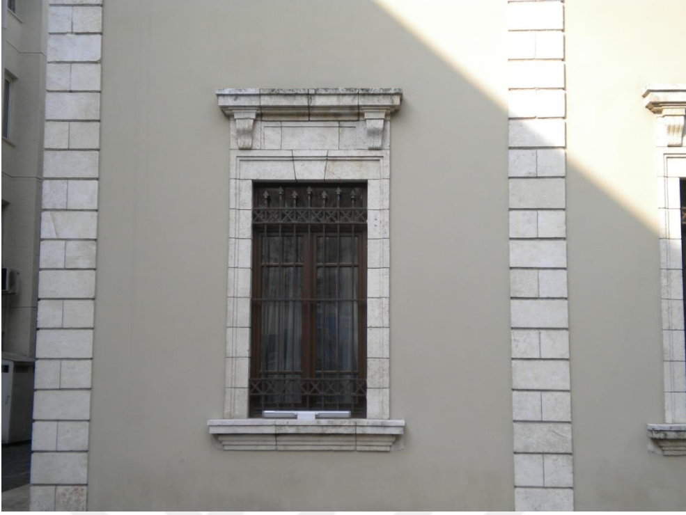
Fotoğraf 5.1.5.4. Hatay Valilik Binası, Pencere Detayı, 2016
