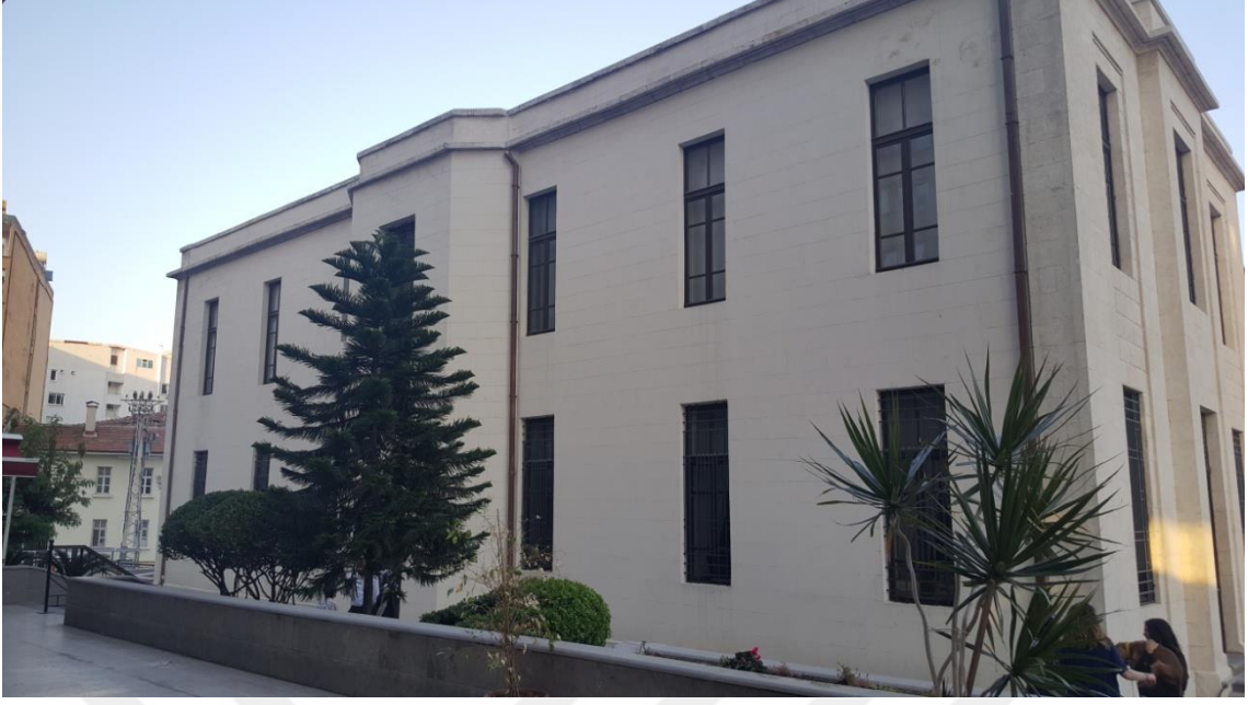
Fotoğraf 5.1.7.3. Antakya Belediye Binası, Batı Cephesi, 2016
