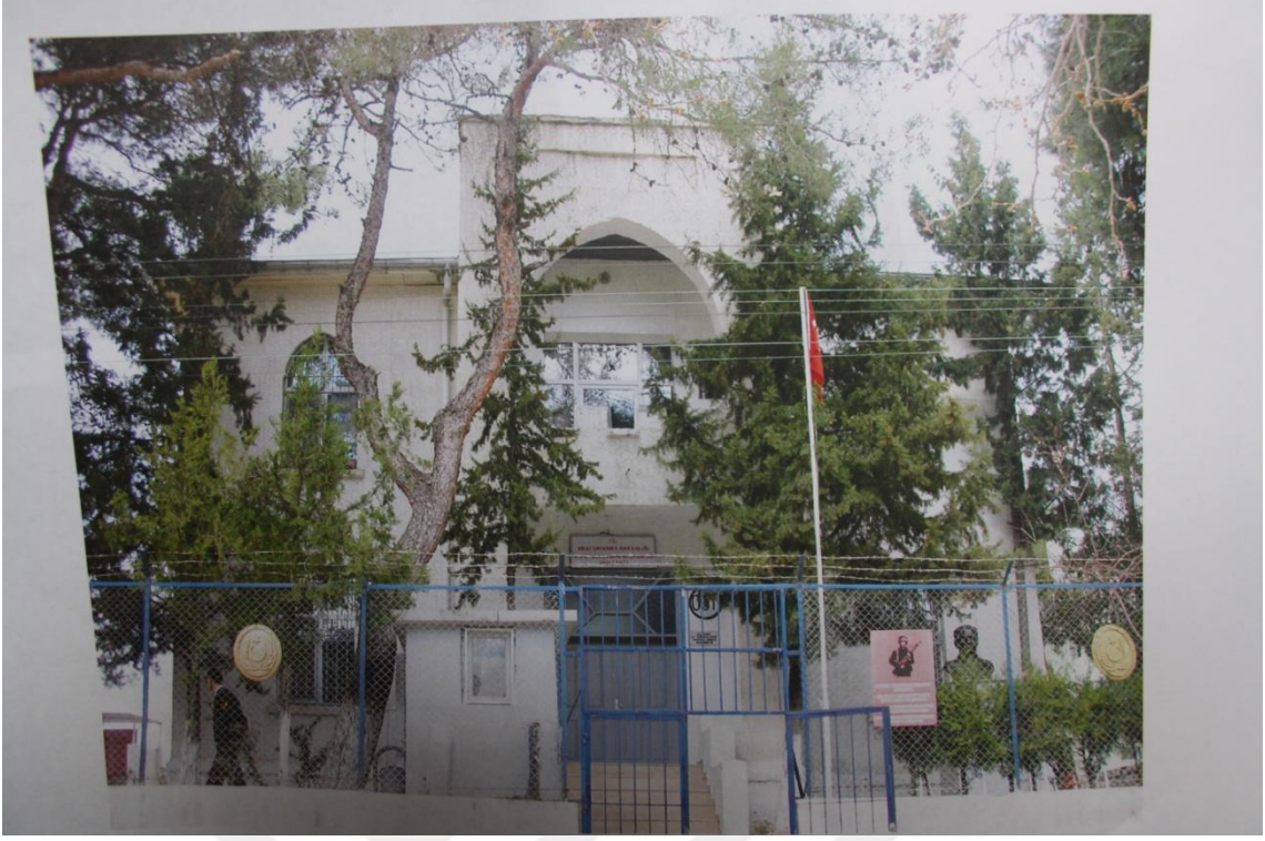
Fotoğraf 5.1.3.1. Yayladağı Hükümet Konağı Güney Cephesi (Kaynak; Adana Kültür Varlıklarını Koruma Bölge Kurulu Müdürlüğü Kurul Arşivi)
