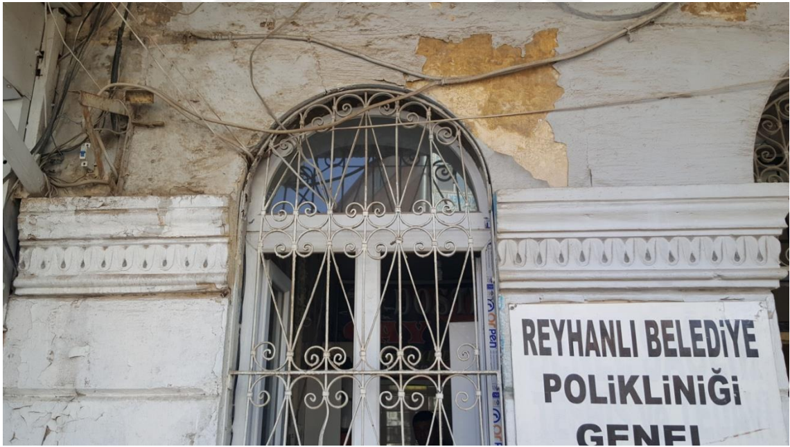
Fotoğraf 5.1.4.6. Reyhanlı Belediye Binası, Batı Cephesi, Bordür Detayı, 2016
