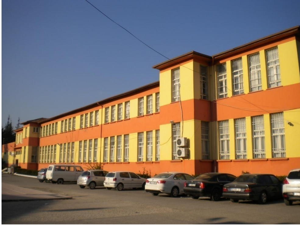
Fotoğraf 5.2.6.4. Antakya Erkek Lisesi, Güney Cephesi, 2016
