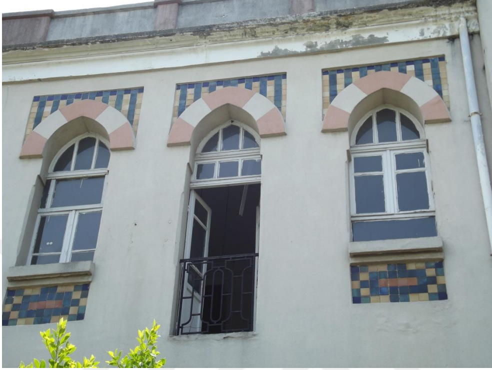
Fotoğraf 5.5.2.10. İskenderun Adliye Binası, Pencere Bezeme Detayı, 2016
