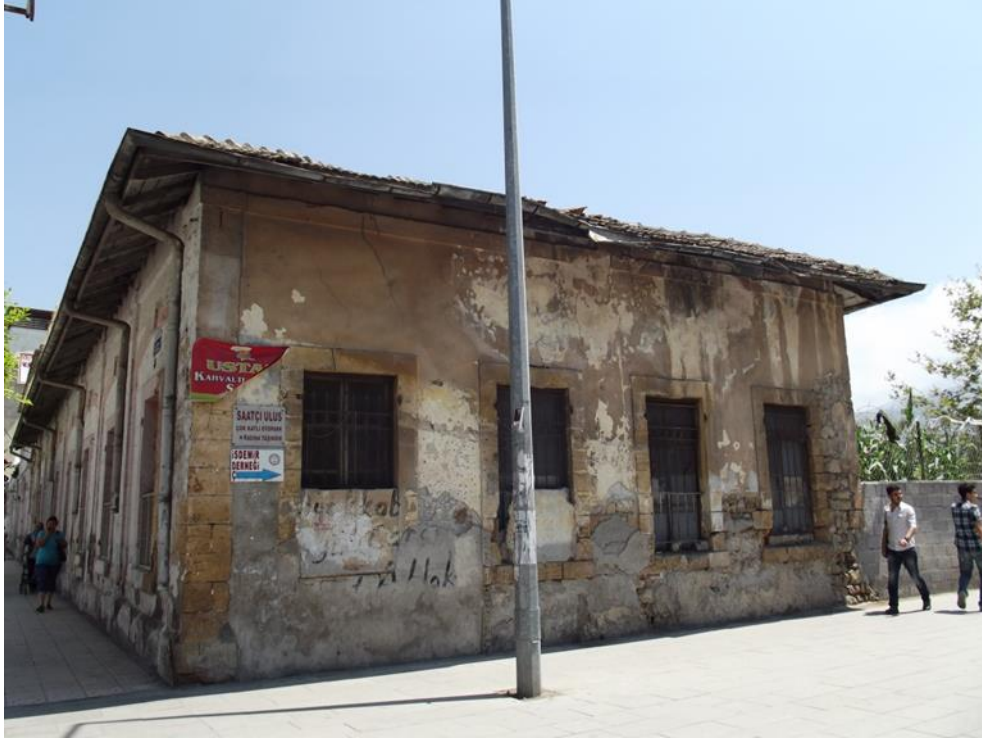
Fotoğraf 5.2.4.2. İskenderun Frerler Okulu, Güney Cephesi, 2016
