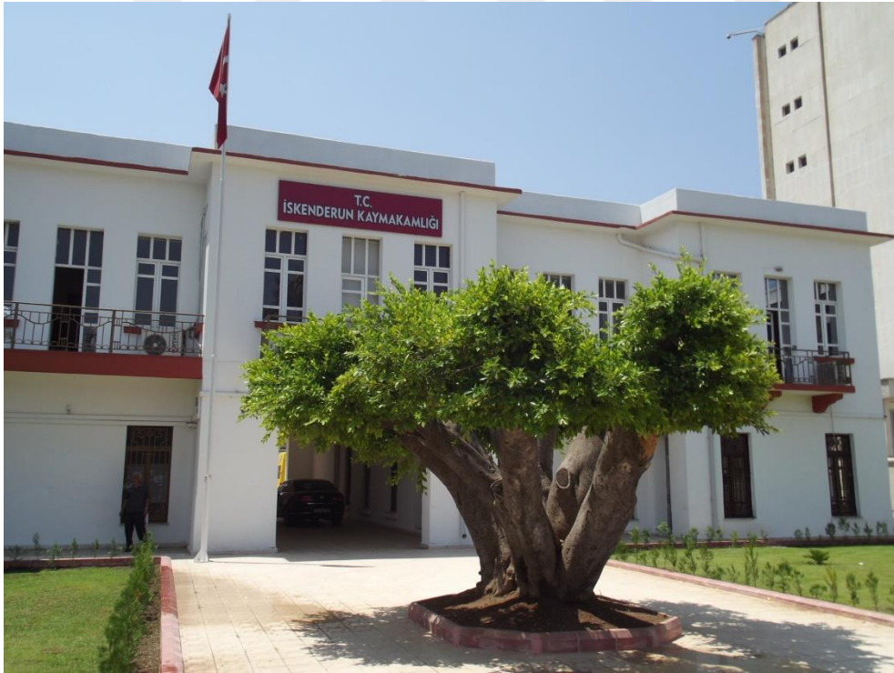
Fotoğraf 5.1.2.4. İskenderun Kaymakamlık Binası, Kuzey Cephesi, 2016
