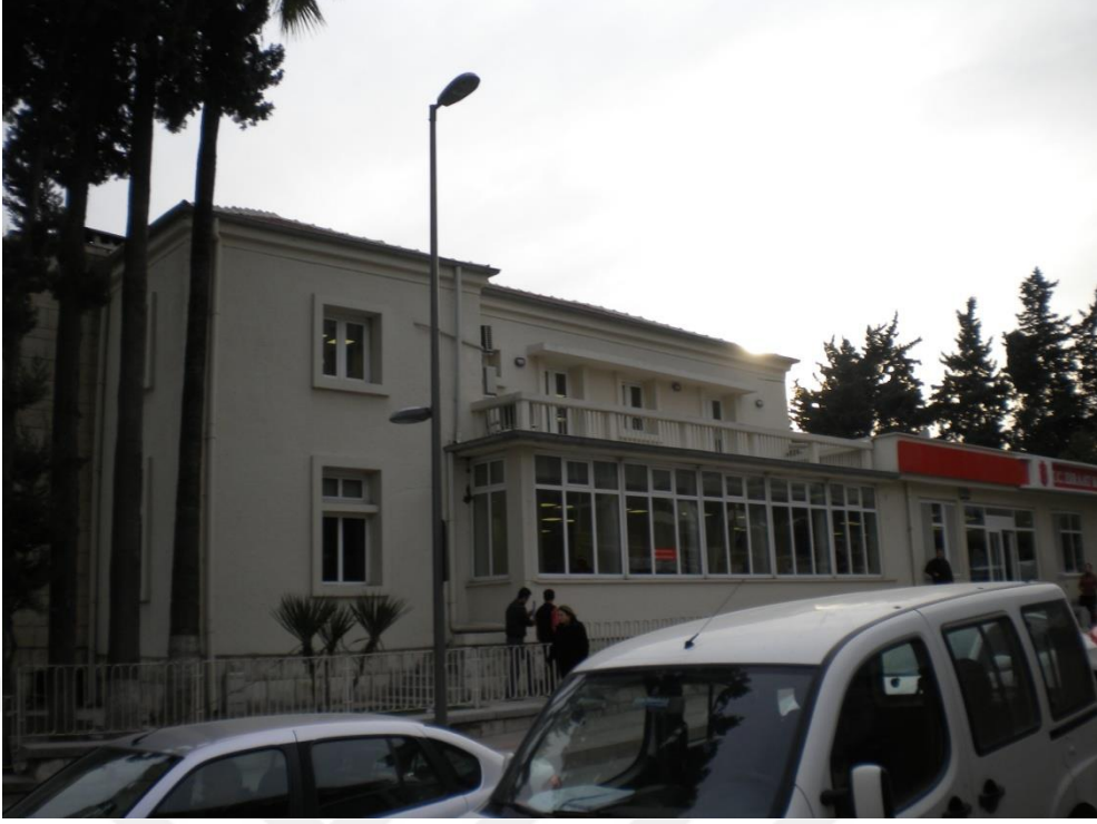
Fotoğraf 5.4.2.3. Antakya Ziraat Bankası, Kuzeybatı Cephesi, 2016
