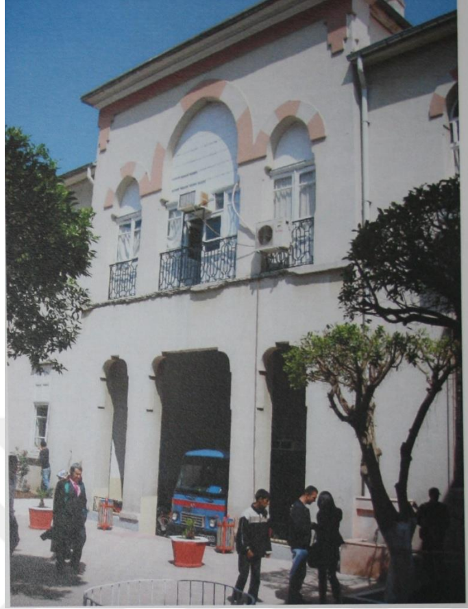
Fotoğraf 5.5.2.8. İskenderun Adliye Binası, Avludan Kuzey Yöndeki Giriş Açıklığı, (Kaynak; Adana Kültür Varlıklarını Koruma Bölge Kurulu Müdürlüğü Kurul Arşivi)
