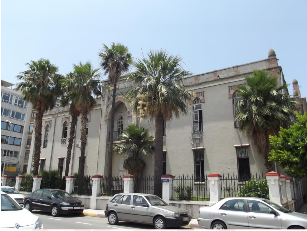
Fotoğraf 5.5.2.6. İskenderun Adliye Binası, Doğu Cephesi, 2016
