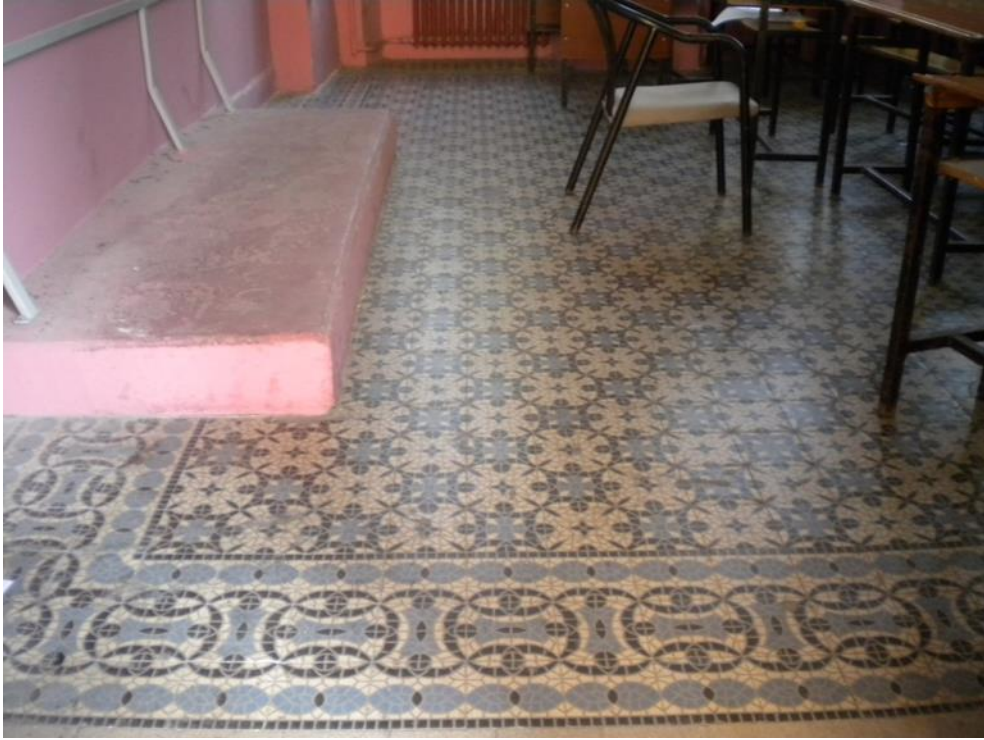
Fotoğraf 5.2.6.6. Antakya Erkek Lisesi, Karo Mozaik Döşemeler, 2016
