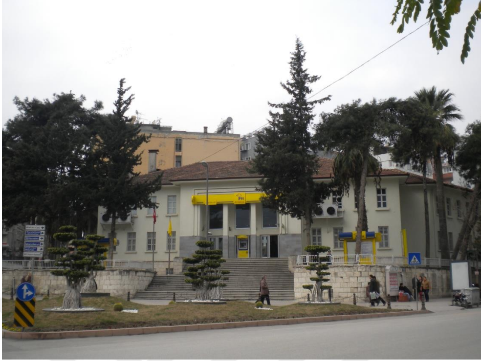
Fotoğraf 5.5.5.1. Antakya Postane Binası, Doğu Cephesi, 2016
