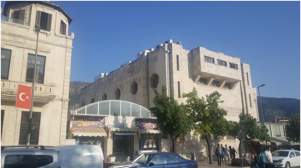
Fotoğraf 5.5.4.4. Antakya Gündüz Sineması, Kuzey Cephesi, 2016
