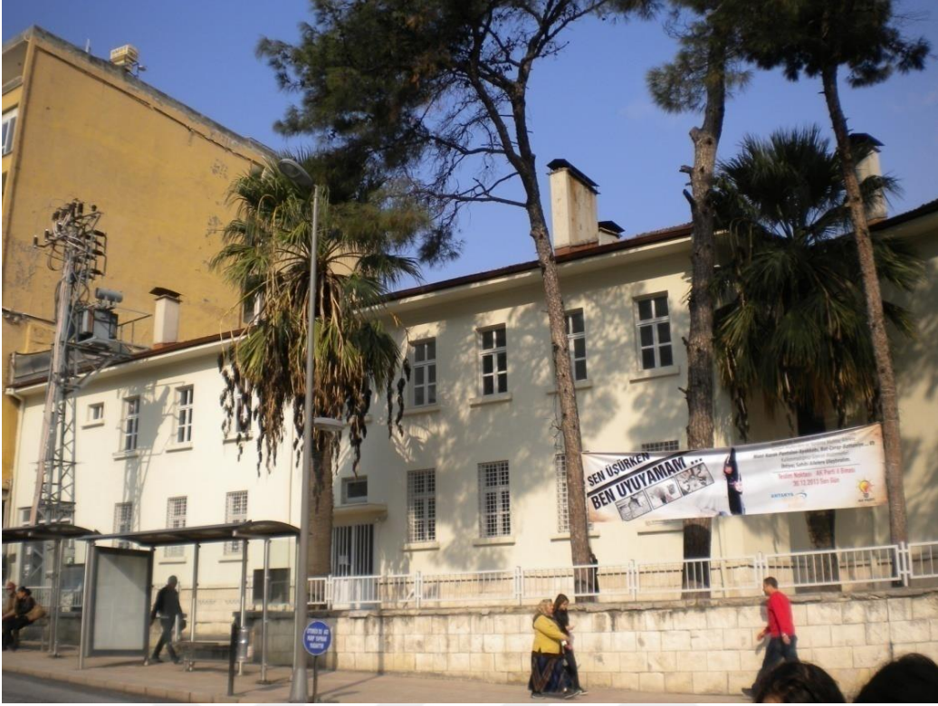
Fotoğraf 5.5.5.3. Antakya Postane Binası, Güneydoğu Cephesi, 2016
