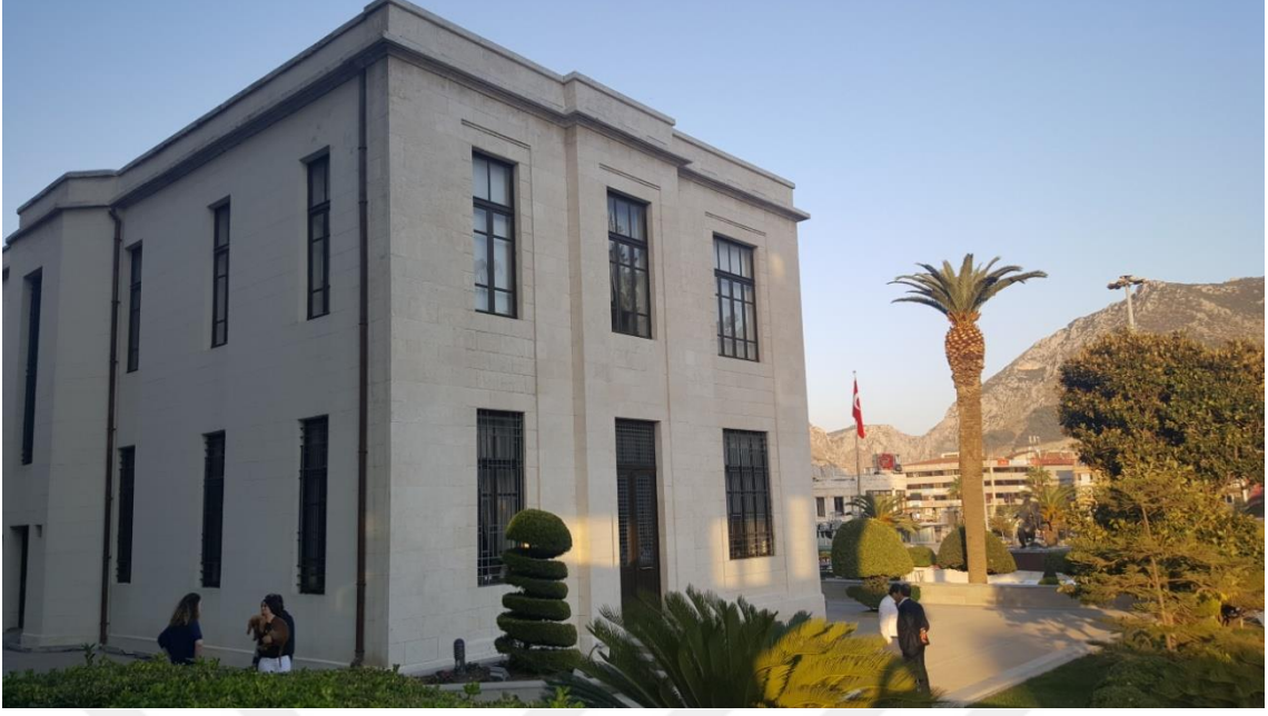
Fotoğraf 5.1.7.5. Antakya Belediye Binası, Güney Cephe, 2016
