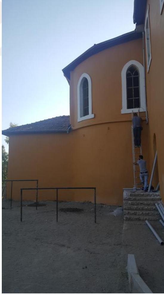
Fotoğraf 5.2.1.2. Kırkhan Ruhban Okulu, Güneydoğu Cephesi, 2016
