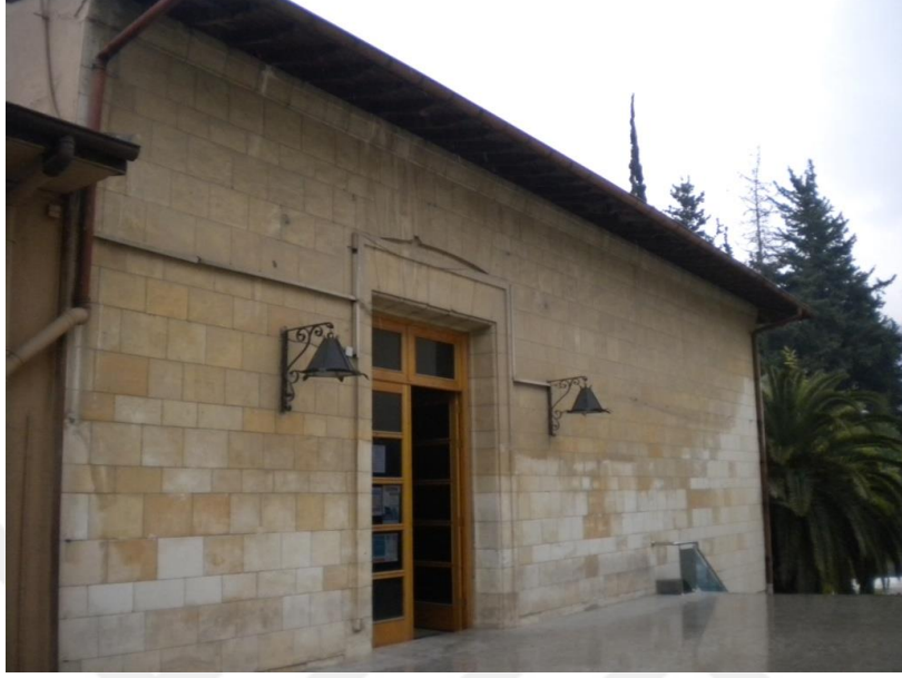
Fotoğraf 5.2.7.3. Antakya Sanat Enstitüsü, Batı Cephesi, 2016
