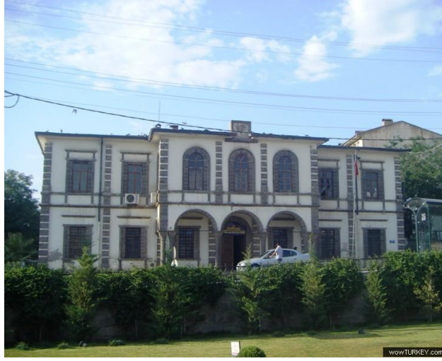
Fotoğraf 14: Siverek Halk Kütüphanesi Binası (Kaynak: http://wowturkey.com )
