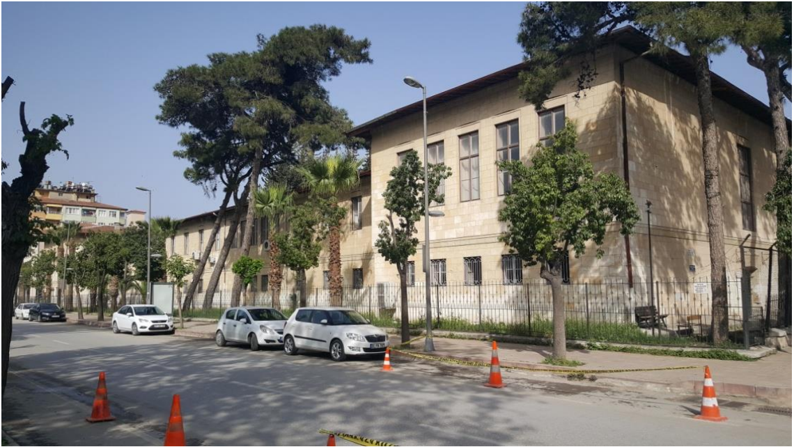
Fotoğraf 5.2.7.2. Antakya Sanat Enstitüsü, Güney Cephesi, 2016
