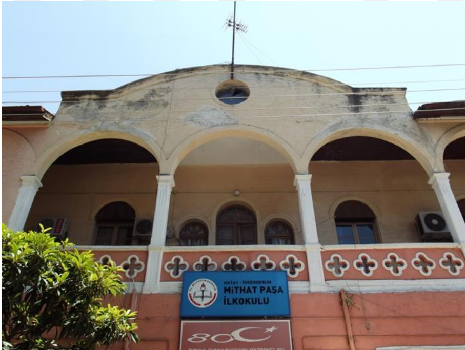
Fotoğraf 5.2.5.11. İskenderun Katolik Fransız Okulu, Batı Cephesi Balkon ve Bezeme Detayı, 2016
