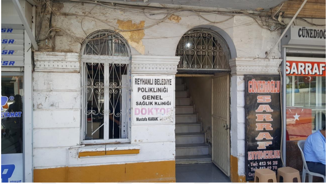
Fotoğraf 5.1.4.5. Reyhanlı Belediye Binası, Giriş Kapısı ve Pencere Detayı, 2016
