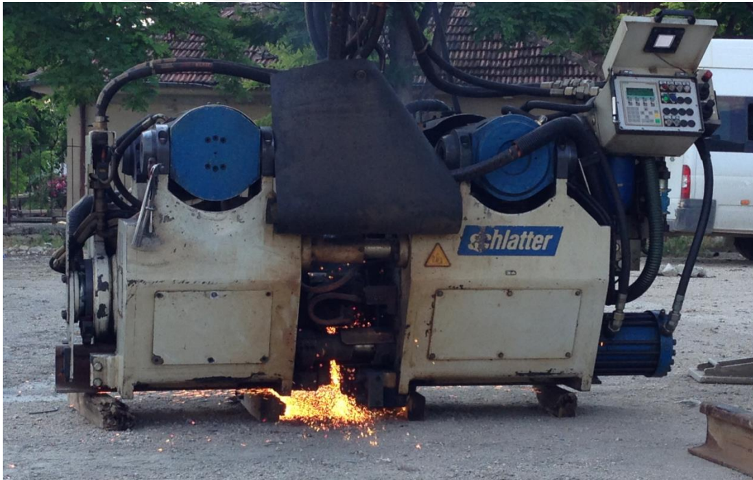
Şekil 2.2. UIC 60 profil raya alın kaynağı işlemi
