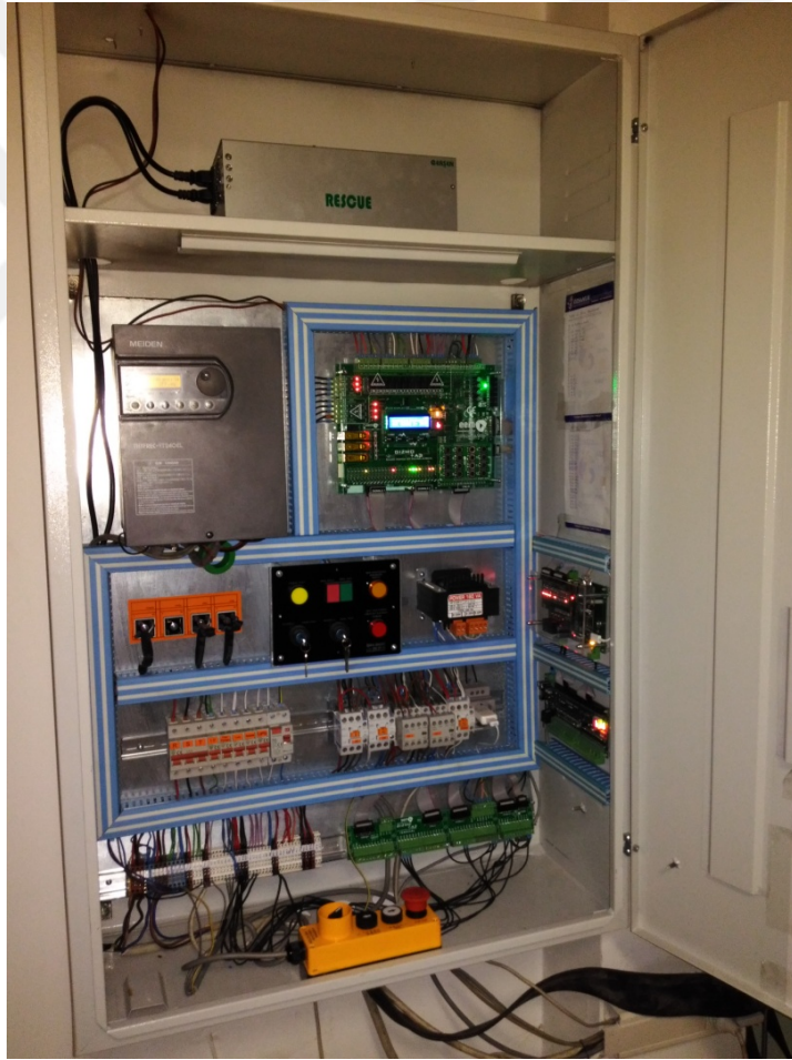
Şekil 6.1. SmartGate uzaktan erişim sistemi bağlanmış asansör kumanda sistemi
