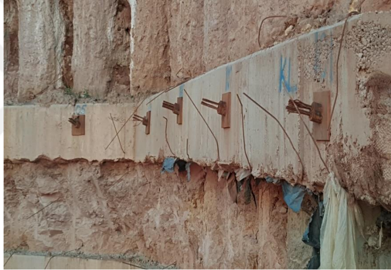
Şekil 5.6: Kuşak kirişi ve ankraj fotoğrafı.
