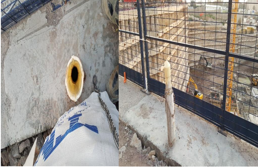
Şekil 3.10: Sahada inklinometre borusu.
