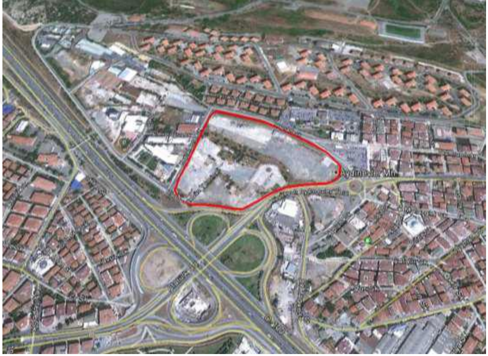
Şekil 5.1: İnceleme alanına ait uydu görüntüsü.
