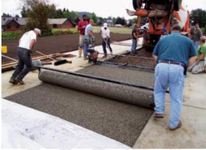
Şekil 2.2. Geçirimli betonun çelik silindirle sıkıştırılma aşaması (Tennis ve ark., 2004).
