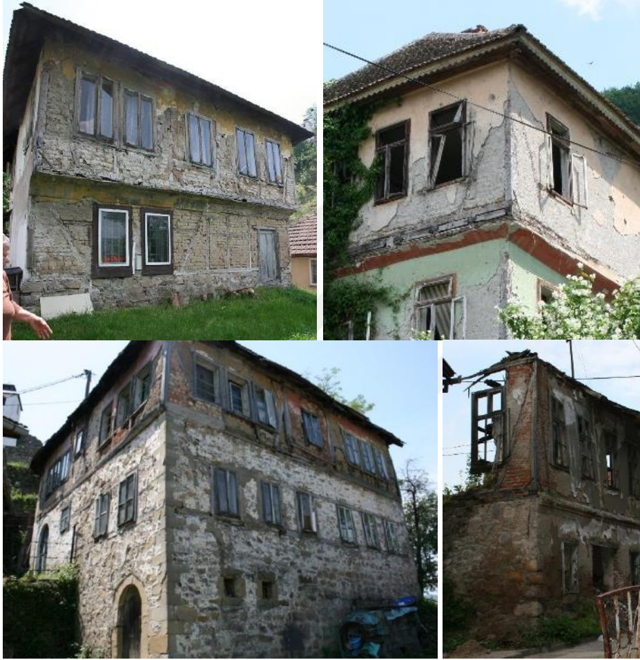
Resim 3.66. Geleneksel evlerde görülen yapıım tekniğine ait örnekler (Nihada Pustahija)
