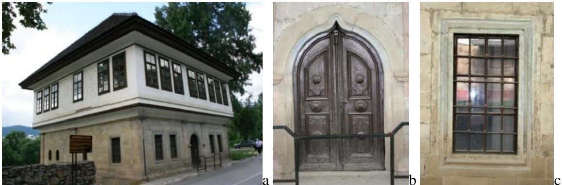
Resim 3.32. (a) Günümüzdeki hanın görünümü, (b) giriş kapısı ve (c) penceresi (Nihada Pustahija)
