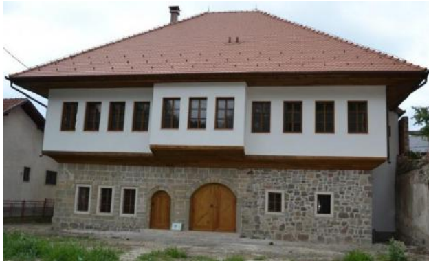
Resim 3.36. Onarımdan sonraki durumu ( http://www.visoki.ba )
