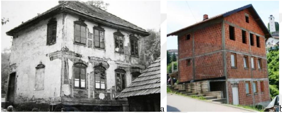
Resim 3.26. (a) Eski mektebin görüntüsü (Maglay Belediyesi) ile (b) yerine inşa edilen konutun görünümü (Nihada Pustahija)
