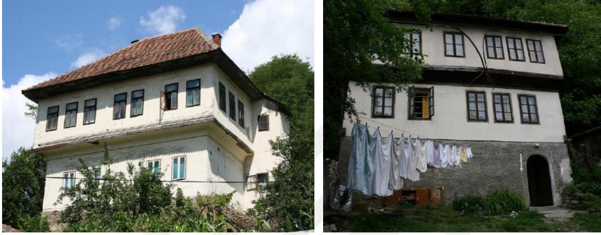
Resim 3.61. Cephe boyunca çıkması olan geleneksel ev örnekleri (Nihada Pustahija)
