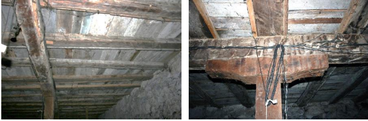
Resim 3.67. Döşeme taşıyıcı sistemi (Nihada Pustahija)
