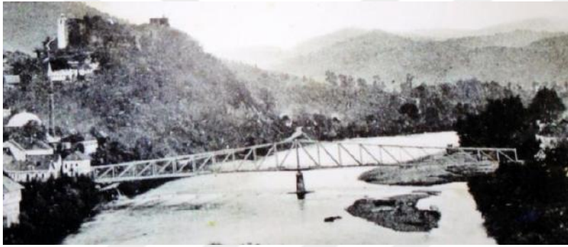
Resim 3.45. Maglay'da demir köprü (Ljuca, 1999)
