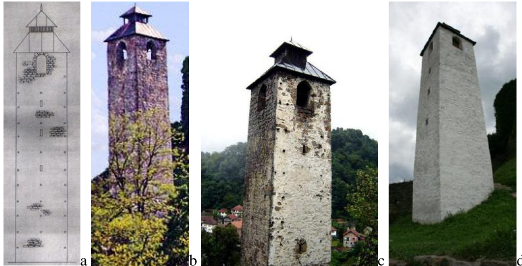
Resim 3.8. (a) Saat Kulesi'nin cephesi (ZFMKS, Sarajevo); (b) Saat Kulesi'nin 1992/95 savaşı'nın öncesindeki görünümü ( http://bosanski-forum.com ); (c) Saat Kulesi'nin savaştan sonraki görünümü (KONS, Sarajevo); (d) Günümüz Saat Kulesi'nin görünümü (Nihada Pustahija)
