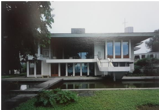
Şekil 3.34. Koç Köşkü Boğaz'a bakan cephe
