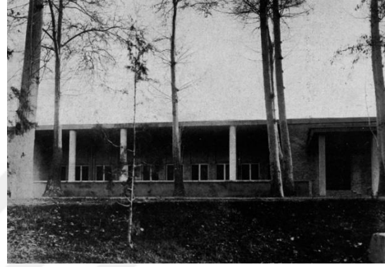
Şekil 2.67. Büyükelçilik Yazlık Binası (1937-38)
