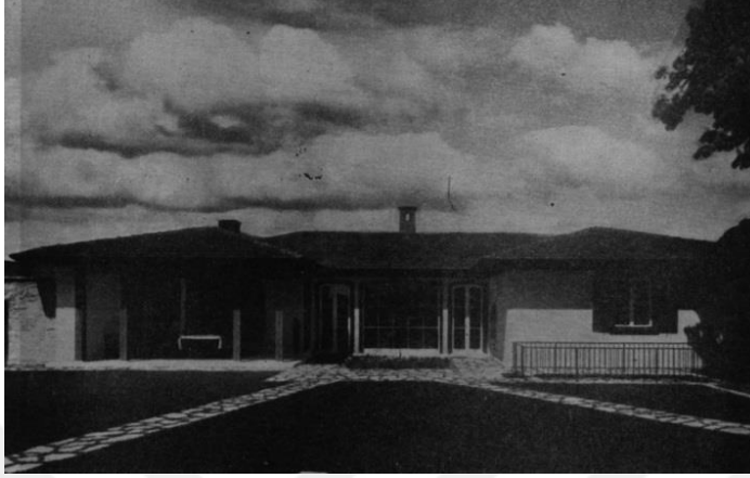
Şekil 3.18. Safyurtlu Köşkü ön görünüşü
