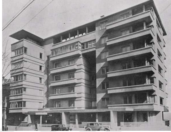
Şekil 2.40. Üçler Apartmanı (1933-34) (Erkan (Arkan) (1935a))
