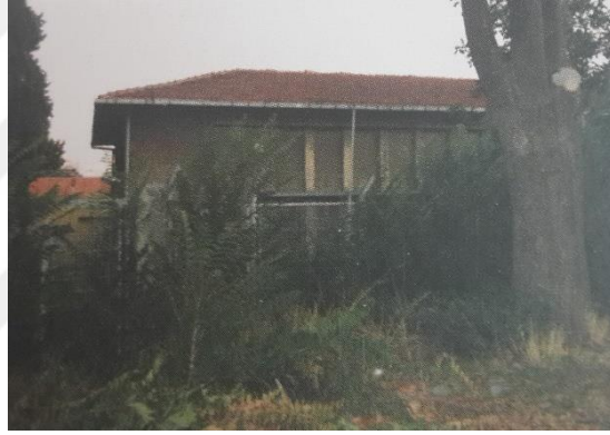
Şekil 2.77. Zeytinburnu Tranformatör Binası
