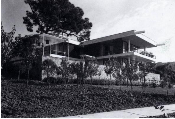
Şekil 3.22. Derviş Manizade Köşkü görünüşü
