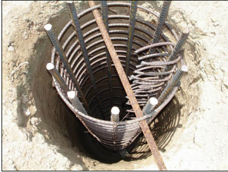
Resim 3.3 Yerinde dökme betonarme akma kazık.
