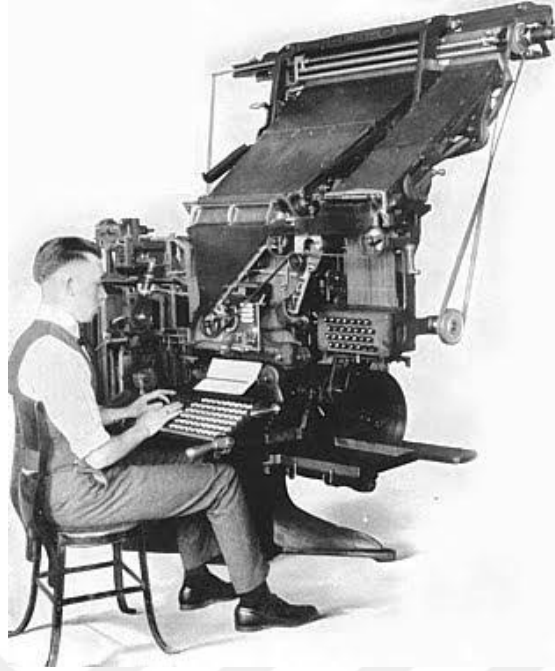
Resim 3.4. Linotip Makinesi 681
