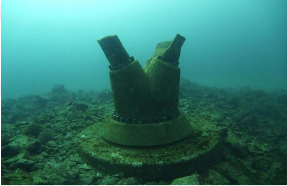
Şekil 2.5: Ördek gaga çek-valflı yayıcı.
