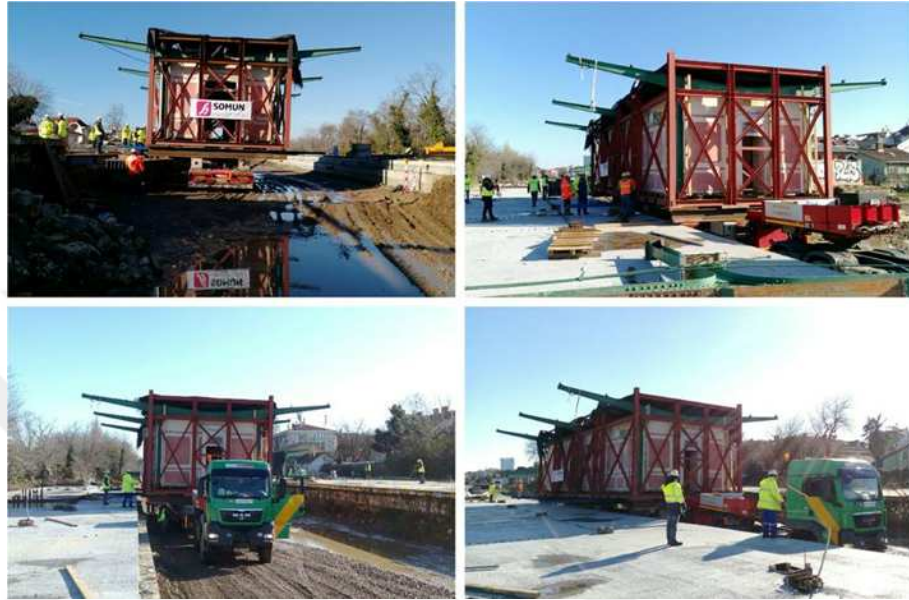
Şekil 1.33. Yeşilköy Tren istasyonu Gar Şeffiği binası'nın taşıma esnasında görünümü [73].
