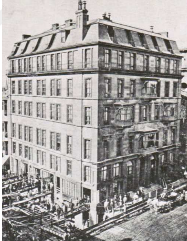
Şekil 1.8. 1869 yılında Boston şehrinde Baylestone caddesinde yapılacak yol genişleme çalışmalarından dolayı Pelham oteli'nin taşınması [29, 38].
