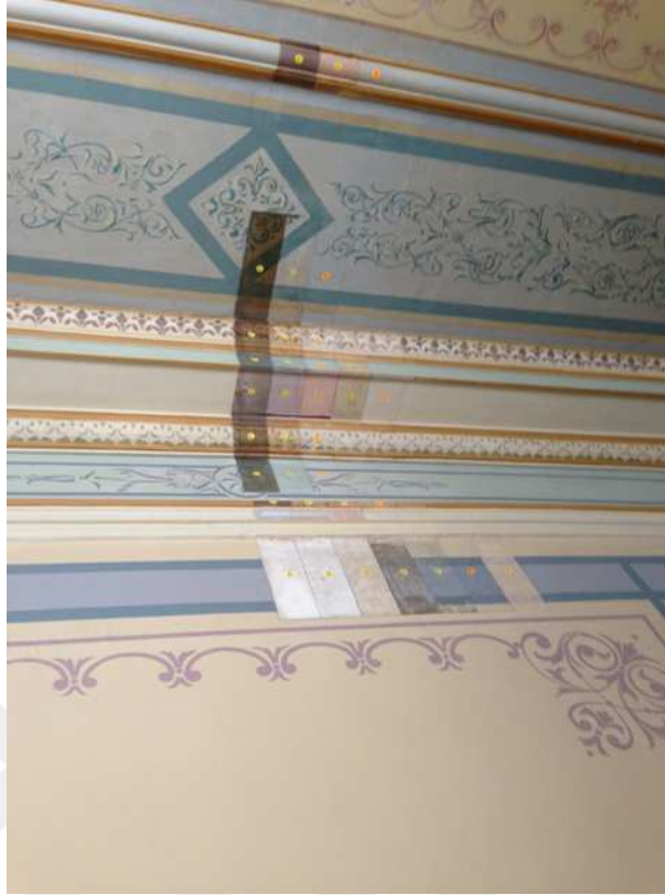
Şekil 1.2. Yıldız Sarayı Harem odaları tavanı restorasyon çalışmalarında, raspa yapıldıktan sonra ulaşılan dönem ekleri, İstanbul (2014) [14].
