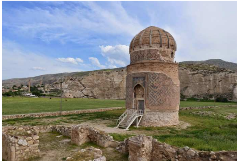
Şekil 1.22. Batman'ın tarihi Hasankeyf ilçesinde bulunan Zeynel Bey Türbesi [52].
