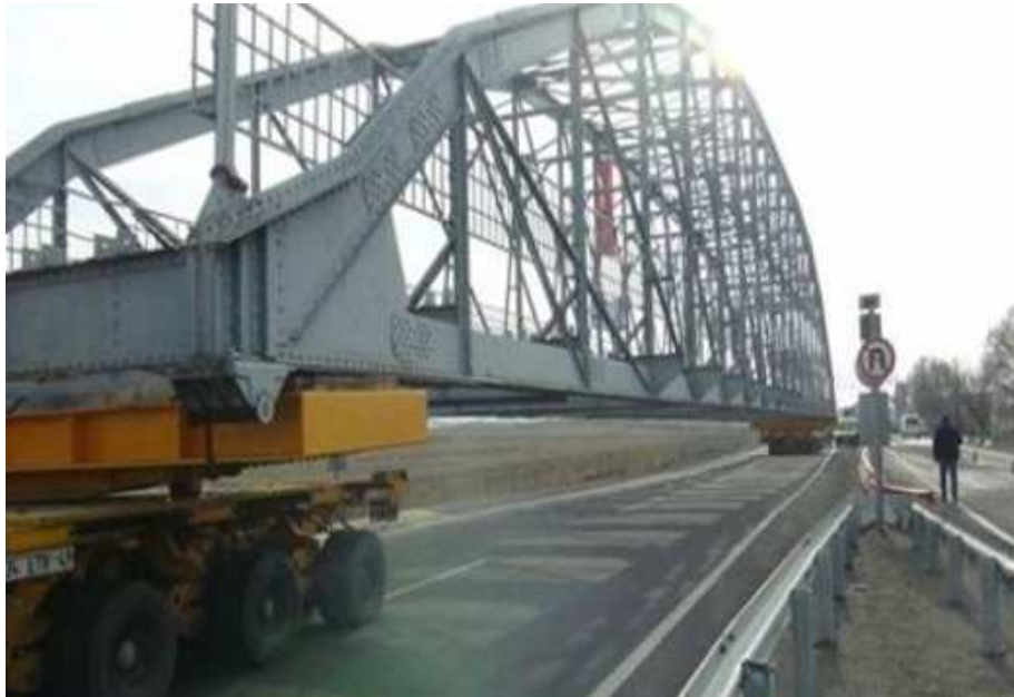
Şekil 1.27. Tarihi Çamçavuş Demir Köprüsü taşınma esnasında [60].
