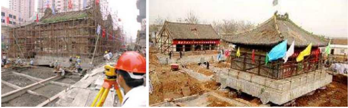
Şekil 1.18. (Solda) Çin'in Qing Dynasty şehrinde bulunan Jinlun Belediye binası, (sağda) Çin'de bulunan Ciyuan tapınağı [31].
