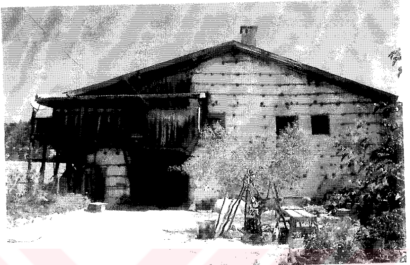
Resim 126: Yusuf Uz Evi Güney Cephesi Dıştan Görüntüsü
