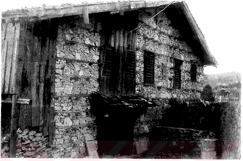
Resim 106: Hasan Uz Evi Güney Cephesi Dıştan Görünüşü
