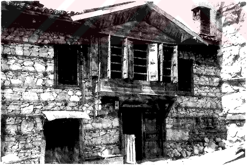
Resim 16: Ahmet Sarıgöl Evi Kuzey Cephesi Dıştan Görünüşü
