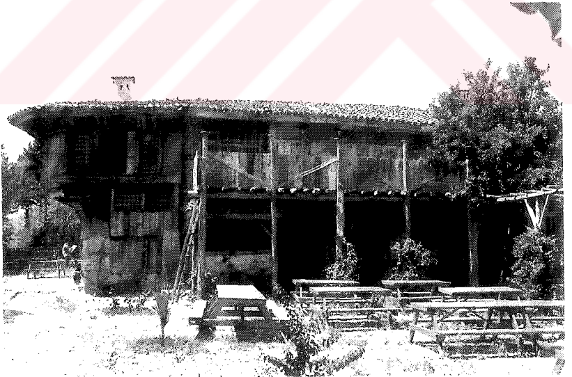
Resim 32: Raşit Altıntaş Evi Doğu Cephesi Dıştan Görünüşü
