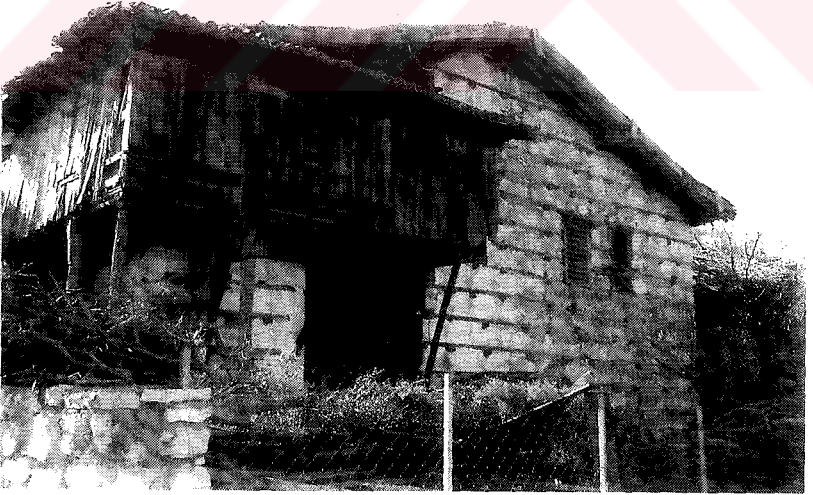
Resim 24: Cemal Bayraktar Evi Güney Cephesi Dıştan Görünüşü
