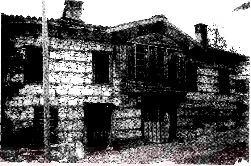
Resim 15: Ahmet Sarıgöl Evi Kuzey Cephesi Dıştan Görünüşü
