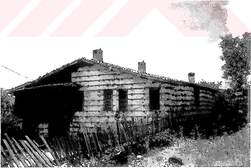
Resim 2: Ali Petek Evi Güney ve Doğu Cephesi Dıştan Görünüşü
