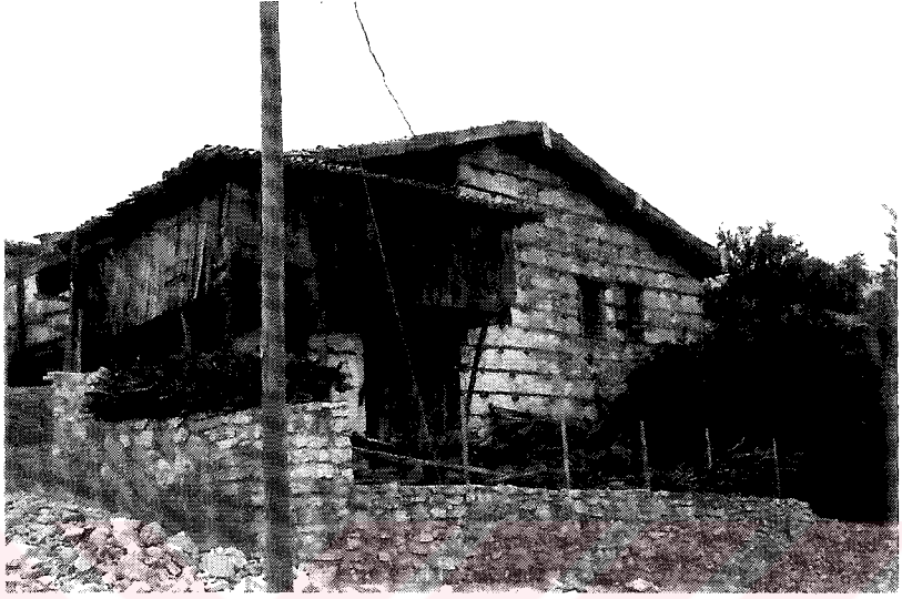
Resim 23: Cemal Bayraktar Evi Güney Cephesi Dıştan Görünüşü
