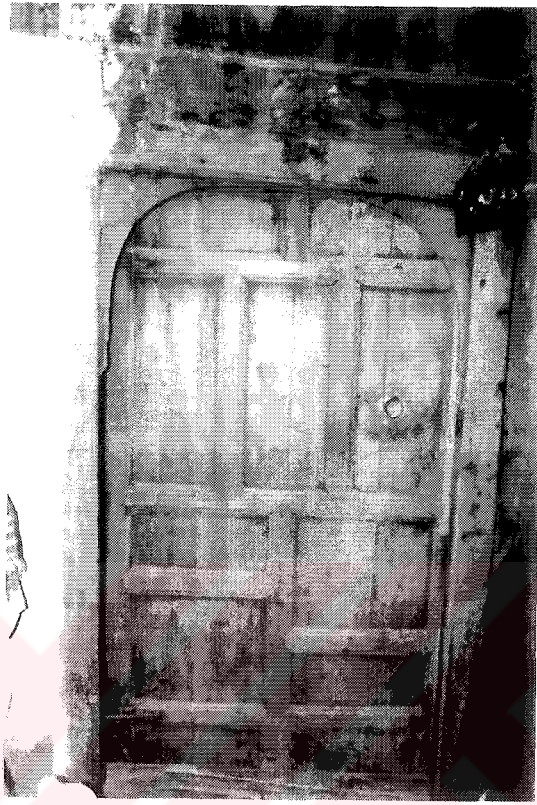
Resim 156: Ahmet Arıcı Evi Güneydoğu Oda Kapısı
