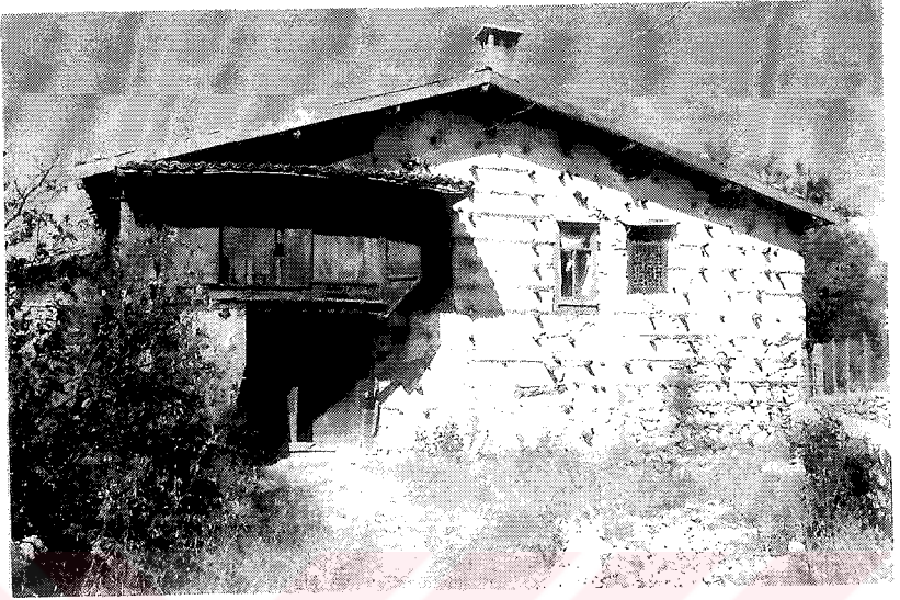
Resim 59: Havva Petek Evi Kuzey Cephesi Dıştan Görünüşü
