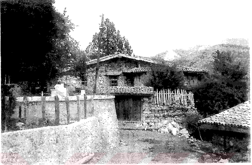
Resim 96: Hasan Arıcı Evi Güney Cephesi Dıştan Görünüşü
