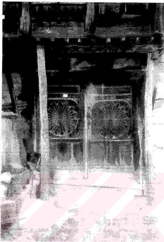
Resim 68: Cavit Erdoğan Evi Ana Giriş Kapısı
