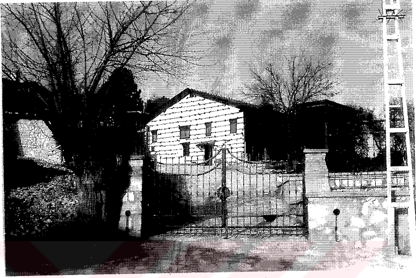
Resim 148: Kerim Aslan Evi Güney Cephesi Dıştan Görünüşü
