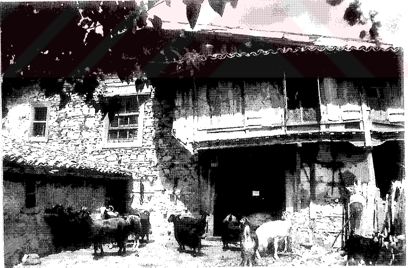
Resim 97: Hasan Arıcı Evi Güney Cephesi Dıştan Görünüşü
