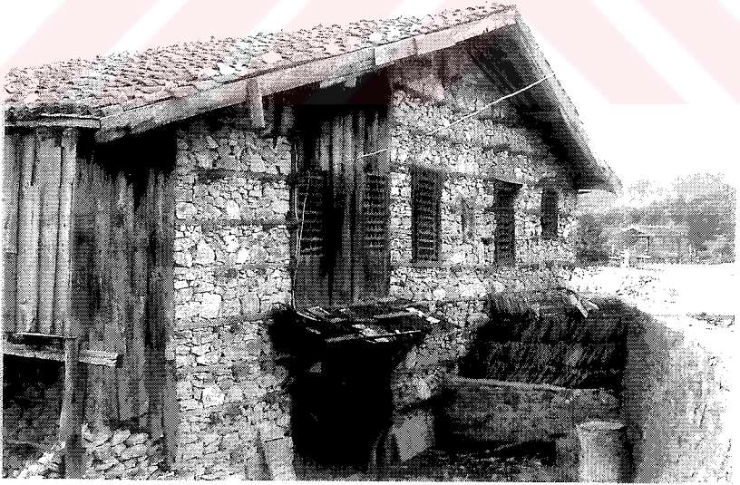
Resim 107: Hasan Uz Evi Güney Cephesi Dıştan Görünüşü
