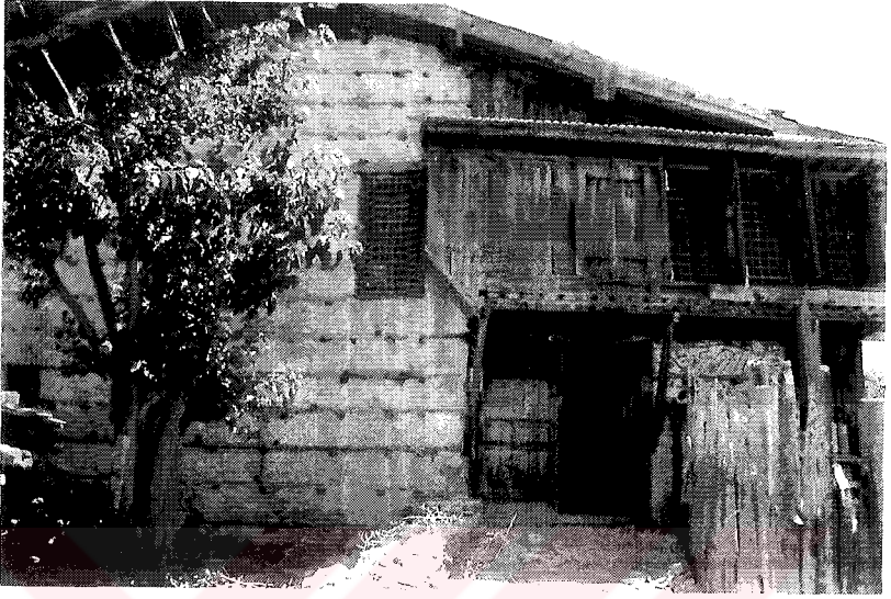
Resim 84: Hasan Baykara Evi Güney Cephesi Dıştan Görünüşü
