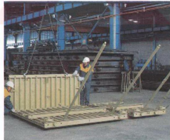
b) Yatay panonun montajı
