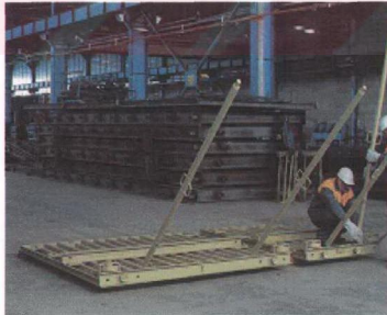
a) Dikey Panonun yerleştirilmesi
