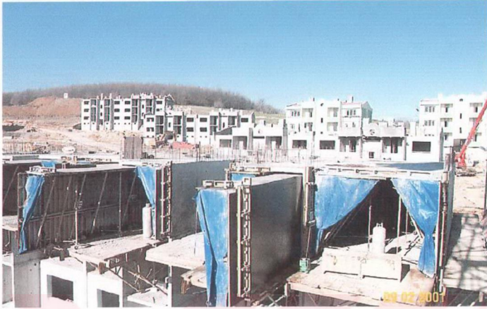
Şekil 2.9. Yarım tünel kalıbın çıkarma iskelesi üzerine sürülmesi
