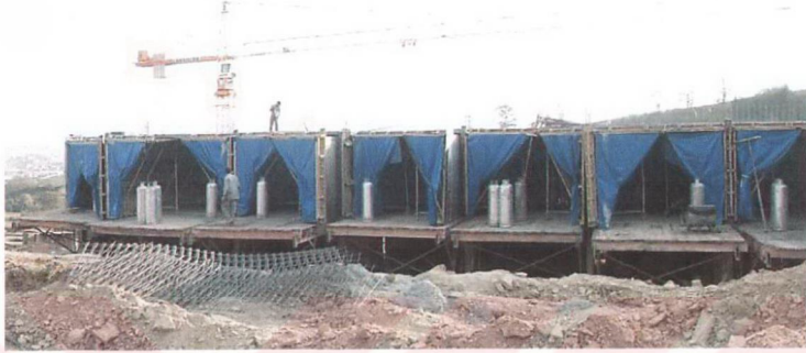
Şekil 2.8 Tünel kalıpta ısıtma sobaları ile kürlleme[1]
