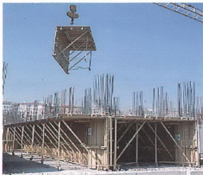
Şekil 2.4. Tünel kalıp elemanının yerleştirilmesi
