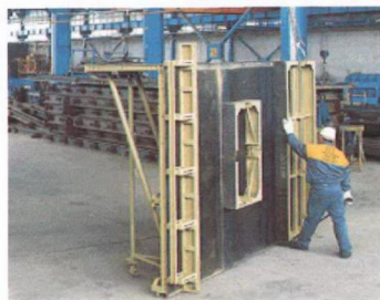
d) rezervasyon kalıbının montajı
