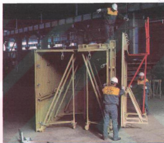
e) iki yarım tünelin birleştirilmesi
