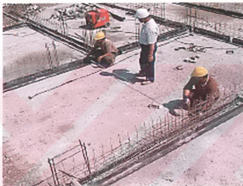
Şekil 2.5. Tünel kalıp sistemde tesisat yerleştirilmesi
