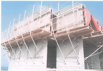
Şekil 2.11. Tünel kalıp çalışma platformu
