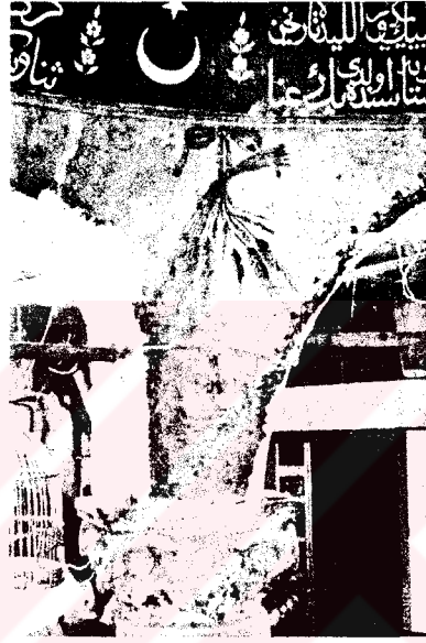
Resim-18: Şadırvanın Pendantiflerinde Yer Alan Bordürlerdeki Alçı İle Müdahale Sonucunda Oluşmuş Bozulmalar
