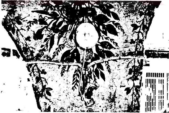
Resim-17: Şadırvan Camii Şadırvanı Pendantifleri üzerine Yerleştirilen Lamba ve Kablolar
