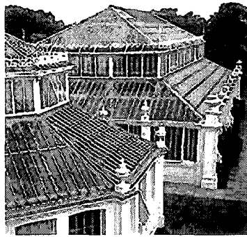
Resim 4.33 Temprate House çatısı ( http://www.greatbuildings.com )
