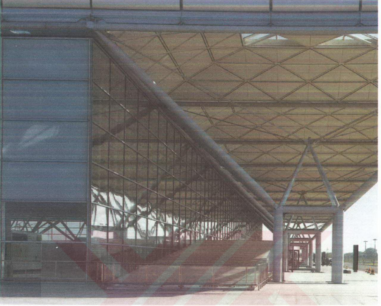
Şekil 10.9.8. Terminal kara tarafı
