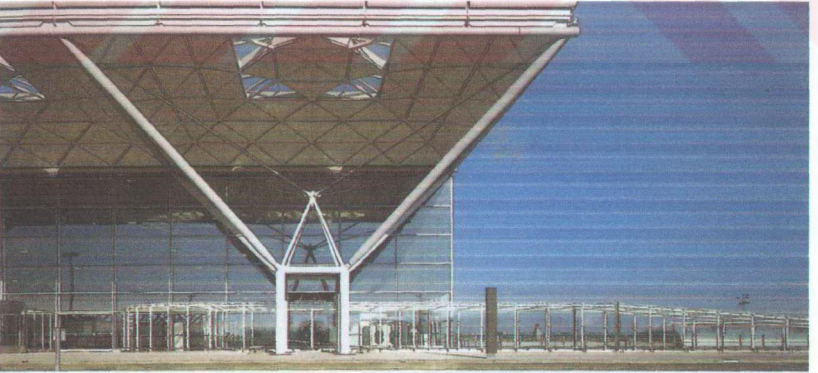
Şekil 10.9.7. Terminal gelen yolcu kapısı
