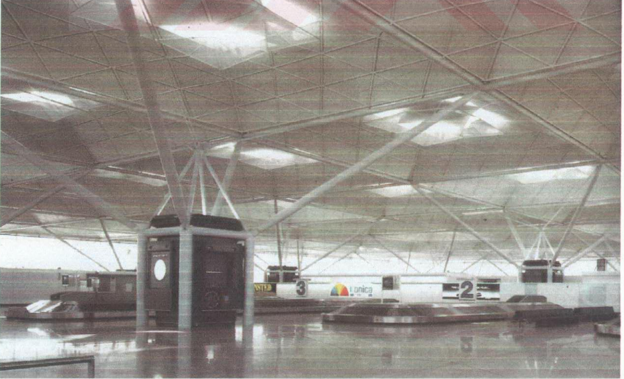
Şekil 10.9.9. Gelen yolcu bagaj alım salonu
