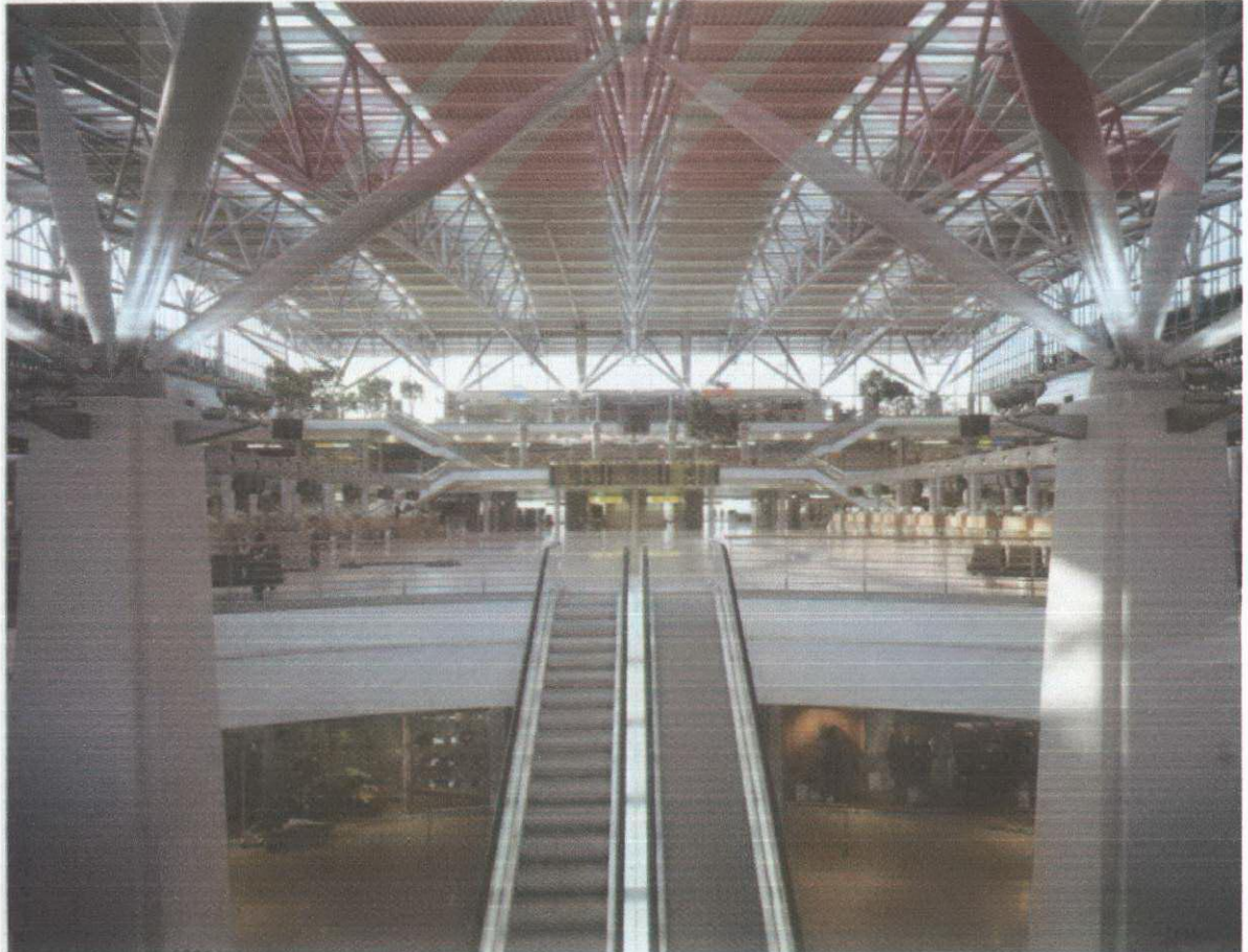
Şekil 10.4.7. Terminal iç görünüşleri
