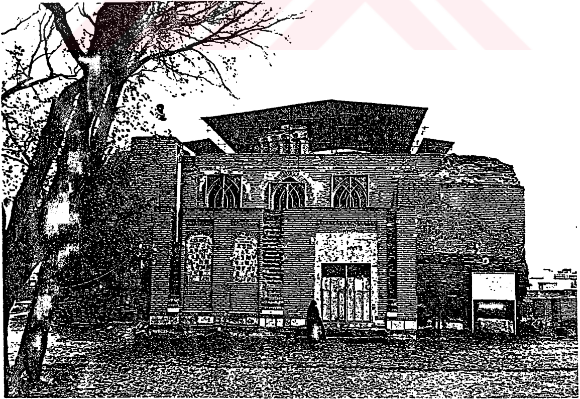
Resim 4.1 Kuzey cephe genel görünüş
