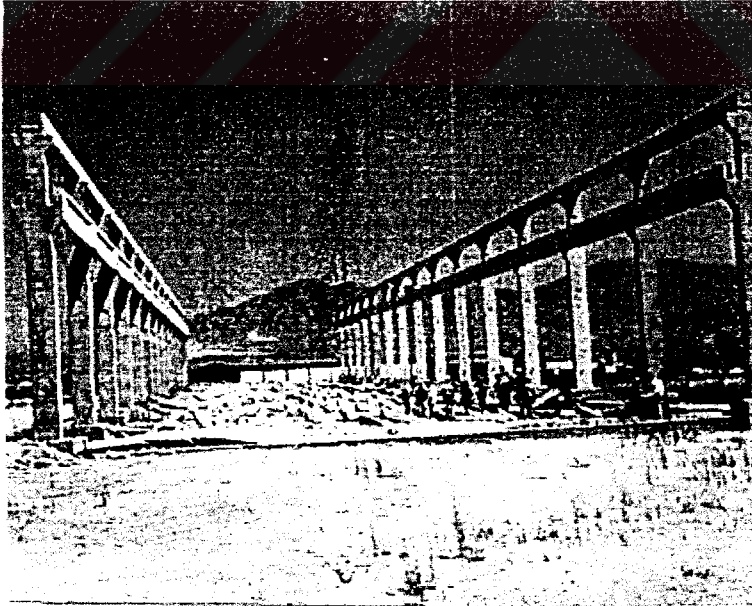
Şekil 6.17. Adana Organize Sanayi Bölgesinde 27 Haziran 1998 Adana-Ceyhan Depreminde hasar gören (a) atölye binası ve (b) yönetim binası kazan dairesinin fotoğrafları (Foto: Reşat Ulusay)..
