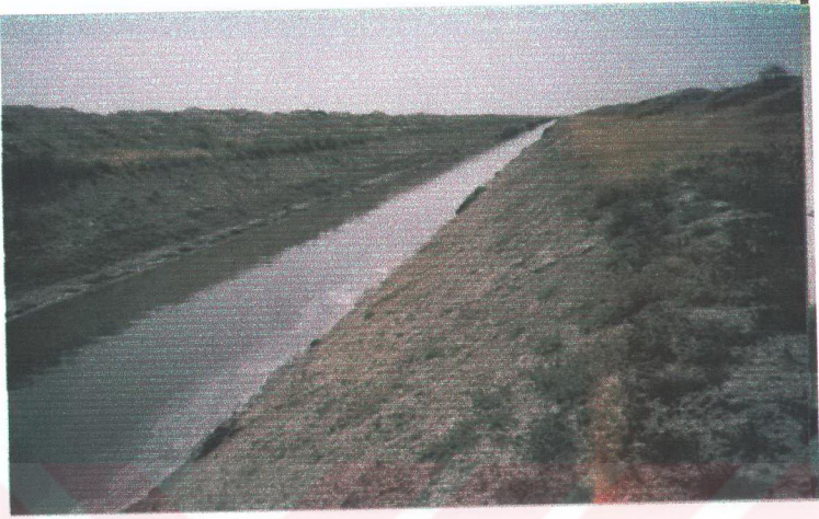
Şekil 3.3.4. Atıksu örneklerinin alındığı ana tahliye kanalı
