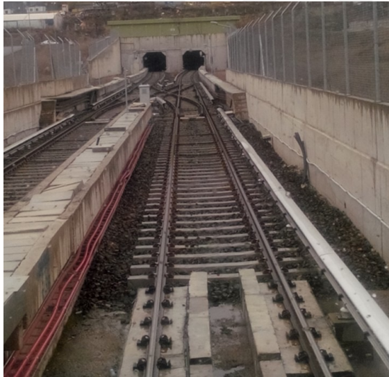
Resim 4.10. Ankara metrosunda korumalı üstten temas uygulamalı 3. ray sistemi
