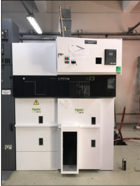
Resim 4.3. Schneider'e ait orta gerilim panosu
