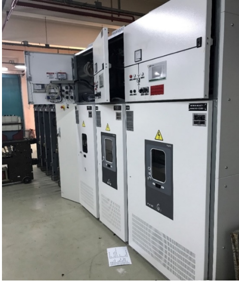
Resim 4.8. Ankara metrolarında kullanılan DC salt panosu
