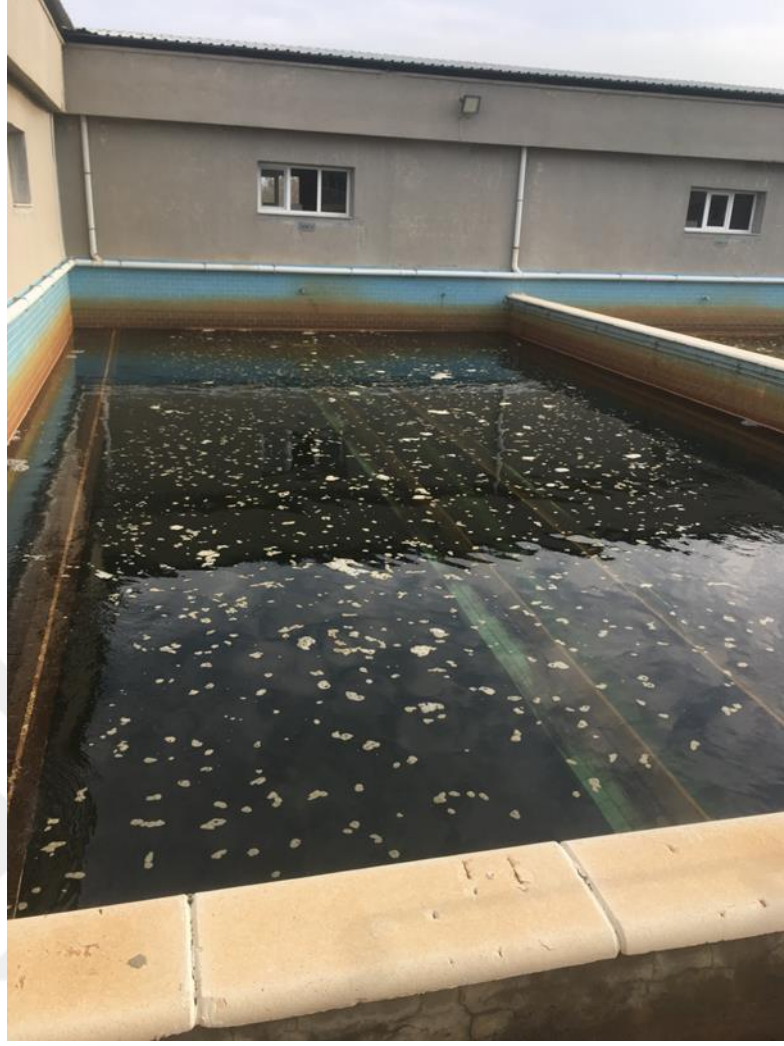
Şekil 3.9. Filtrelerin dolu hali.
