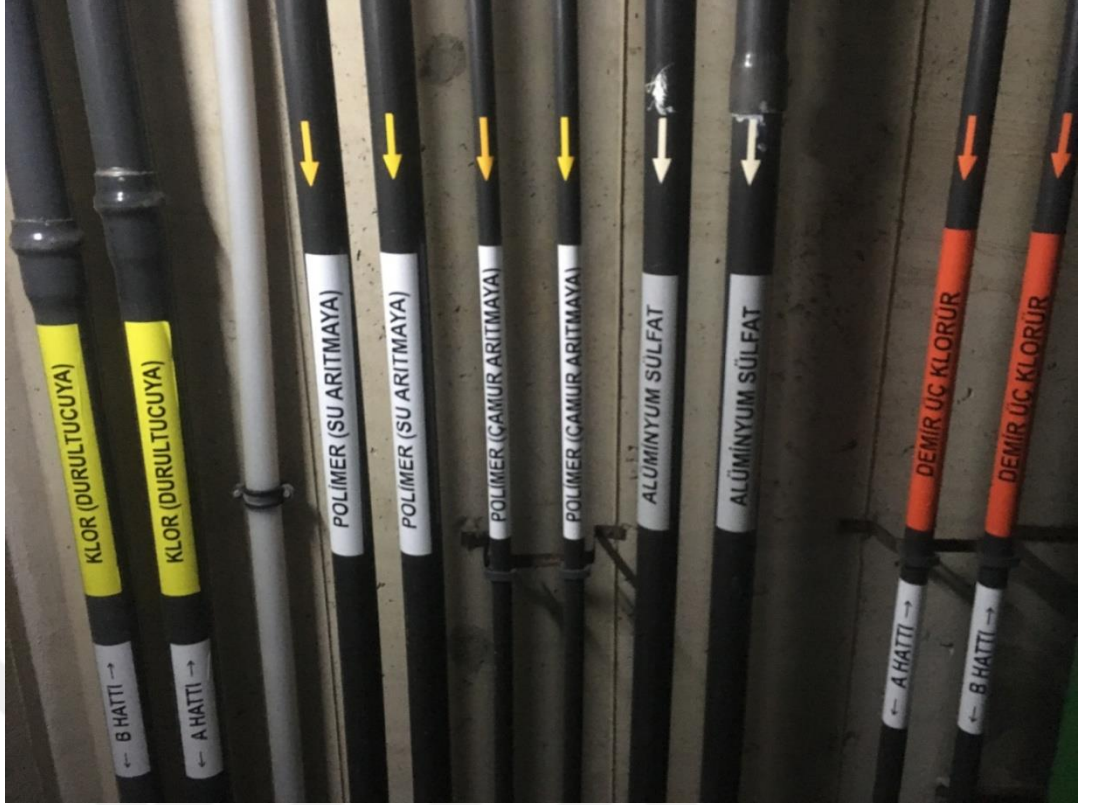
Şekil 3.5. Kimyasal Dozlama Boruları
