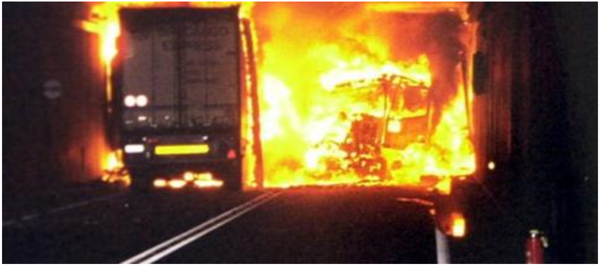
Resim 1.2. Gotthard tüneli yangını (Ingason, 2003)
