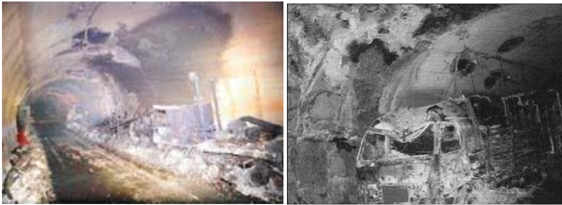
Resim 1.1. Mont Blanc tüneline oluşan hasar (Ingason, 2003)
