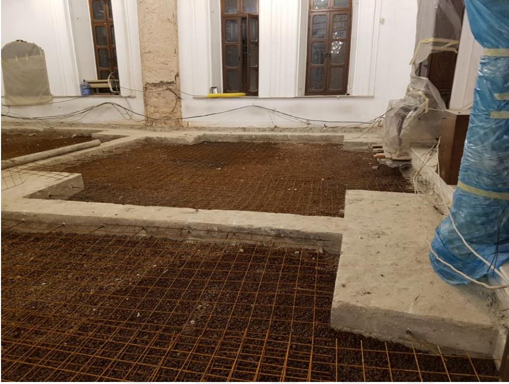
Şekil 4.2 Zemin iyileştirme örneği (Konak Hisar Camii).
