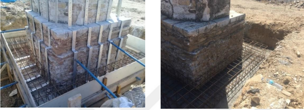
Şekil 4.6 Minare temeline ve kaidesine Takviye (Tire Rahmanlar Minaresi).
