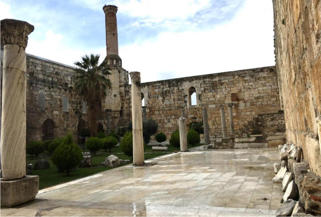
Şekil 5.4 Cami iç avlusu (Doğu cepheden).
