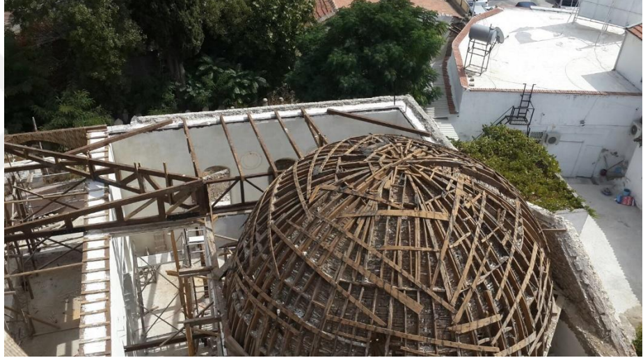
Şekil 4.5 Çatıda ahşap makas ve karkas onarımları (Menemen Mahkeme Cami).
