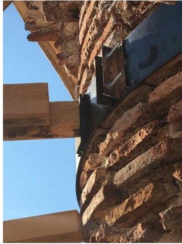
Şekil 5.24 Minare gövdesine ek çelik bilezik uygulaması ve ahşap destek iskelesinin kauçuk ile yapıya bağlanması.
