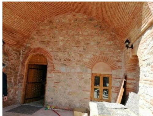
Şekil 4.4 Kemer ve tonoz onarımları (Sırasıyla Manisa İlyasbey ve Gölarmara Şahuban Camileri).
