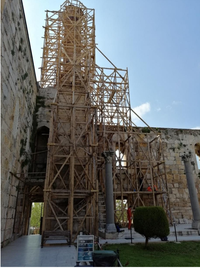
Şekil 5.23 Minare destek iskelesi tamamlanmış hali.
