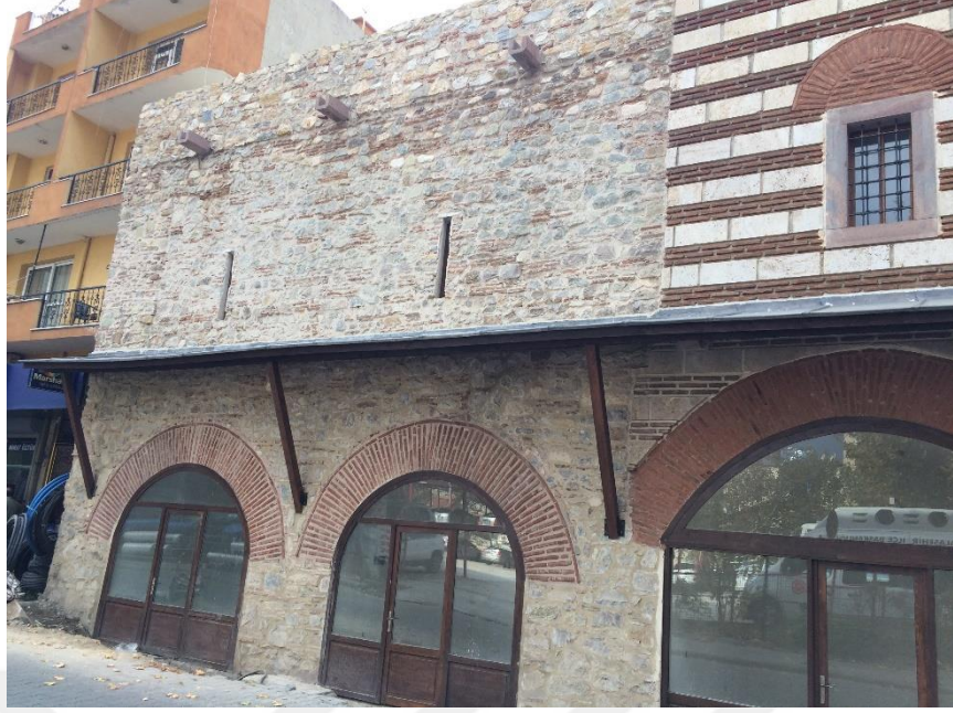
Şekil 4.1 Onarım- sol yan ve tamamlama - sağ yan örneği (Alaşehir Kurşunlu Han).
