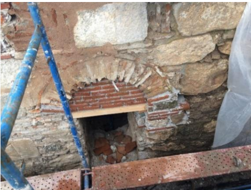
Şekil 4.4 Kemer ve tonoz onarımları (Sırasıyla Manisa İlyasbey ve Gölarmara Şahuban Camileri).
