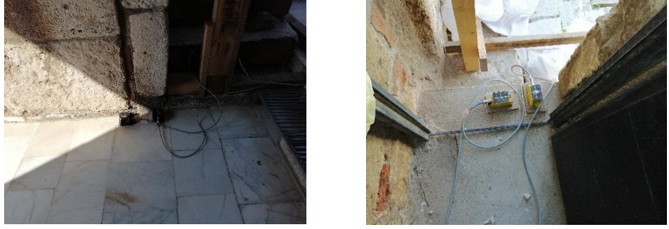
Şekil 5.31 Kaide-zemin ve minare girişi ivme ölçerler-iskele sonrası.
