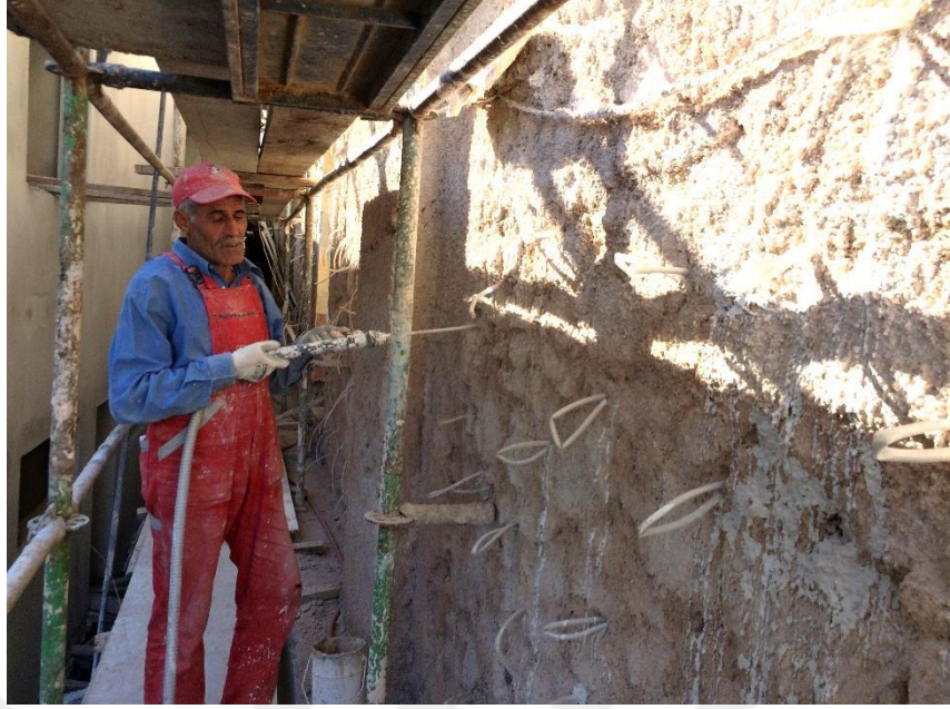
Şekil 4.3 Kireç enjeksiyon uygulaması (Konak Yapıcıoğlu Camii).
