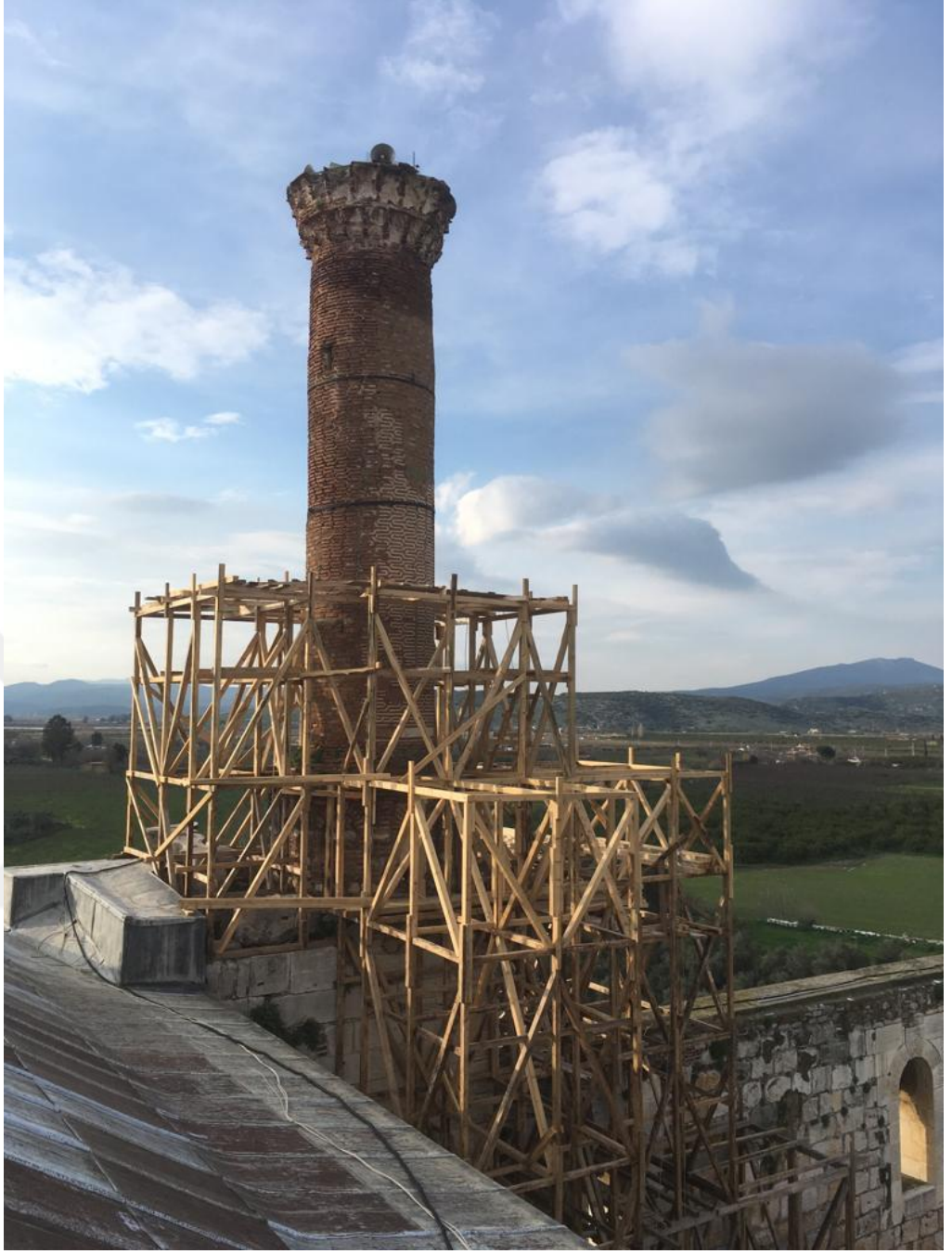
Şekil 5.22 Minare destek iskele yapılma çalışmaları.
