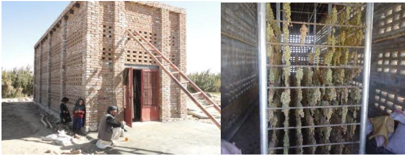
Şekil 1.4 Yeni model kurutma evi ve üzümlerin kurutulduğu raf askılar
