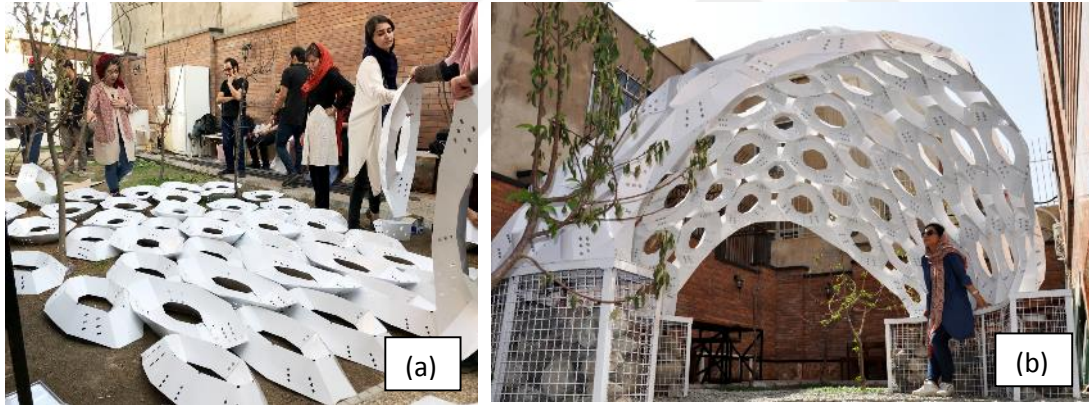
Resim 4.25. (a) Dijital haritalama yöntemi ile oluşturulan modüller, (b) Deneysel strüktürün sonlandırılmış hali (URL-41)
