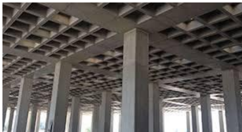
Resim 5.3. Kolon kiriş çerçeve uygulama örneği
