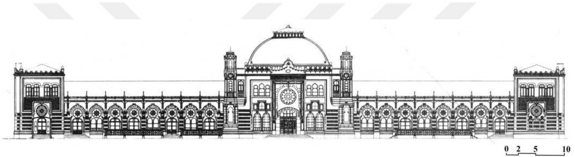
Şekil 2.3. Sirkeci Garı giriş cephesi [19]
