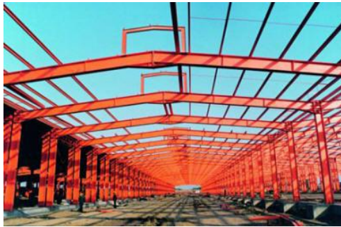
Resim 5.2. Rijit çerçeve uygulama örneği
