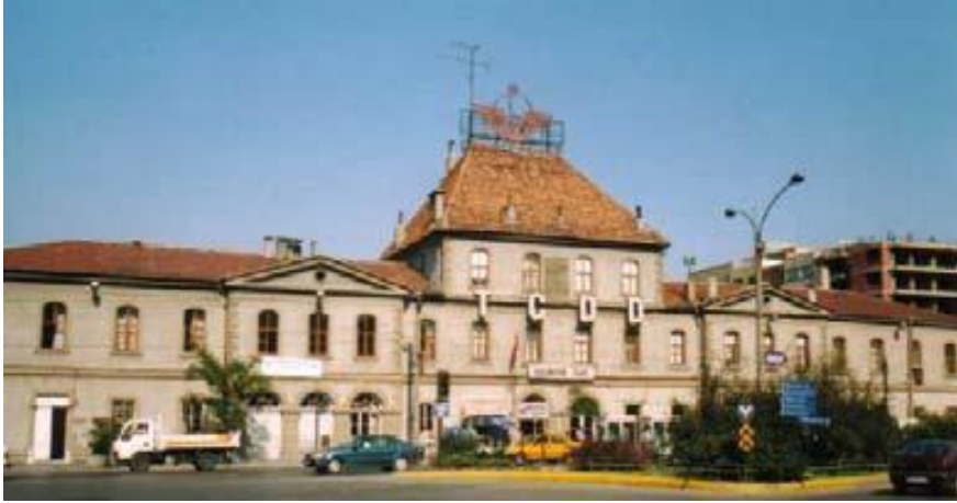
Resim 2.17. Basmane Garı giriş cephesi
