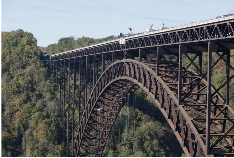
Resim 5.4. Kemer sistem örneği, Portekiz demir köprü
