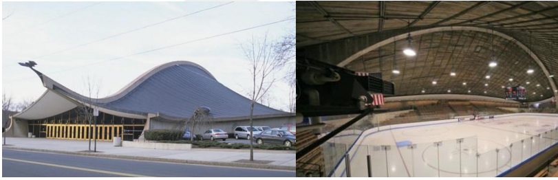
Resim 5.7. Ingalls buz hokeyi salonu, çatı, cephe ve iç mekandan görüşler
