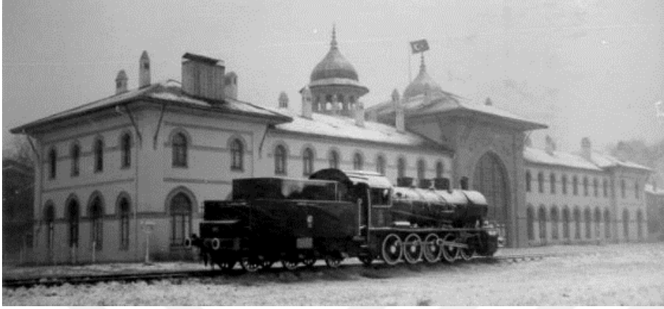
Resim 2.21. Edirne Garı arka cephesi
