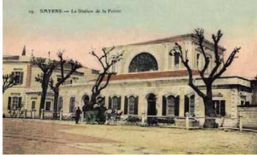
Resim 2.16. Alsancak Garı giriş cephesi
