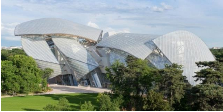
Resim 5.15. L.V.F. binası görünüşü
