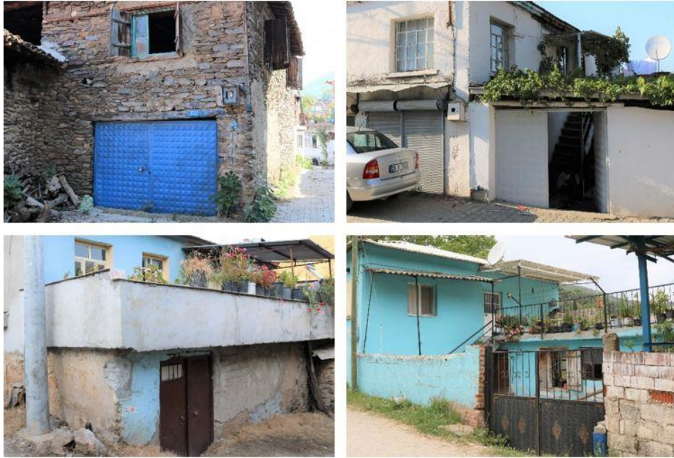
Şekil 5.55 Eğridere köyünde kaplamalar ile yol kotunun yükselmesi sonucu toprak altında kalan giriş örnekleri (Kişisel arşiv, 2018)
