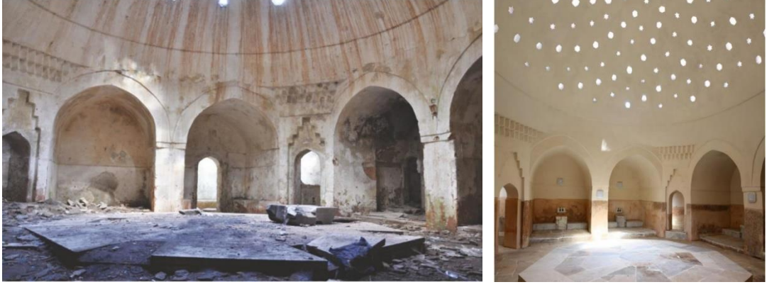
Şekil 3.40 Yalınayak Hamamı'nın erkekler bölümü sıcaklık mekanının restorasyon öncesi ve sonrası görünümü (T.C. Tire Belediyesi, b.t)
