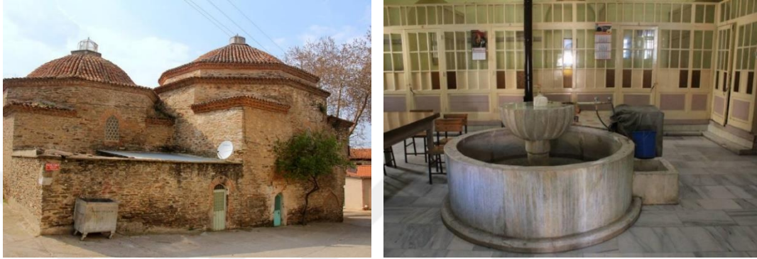
Şekil 3.37 Eski Yeni Hamamı kadınlar ve erkekler bölümü giriş cephesi ile erkekler soyunmalık bölümünde bulunan havuz (Şaşmaz, 2012)
