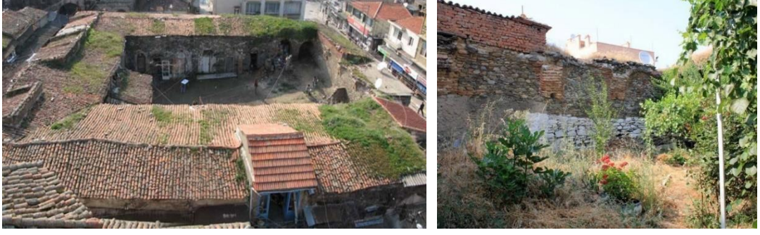
Şekil 3.30 Çöplüce Hanı genel görünümü (İzmir Yüksek Teknoloji Enstitüsü, Mimari Restorasyon Bölümü, 2008) ve avludan görünümü (Gürelli, 2013)
