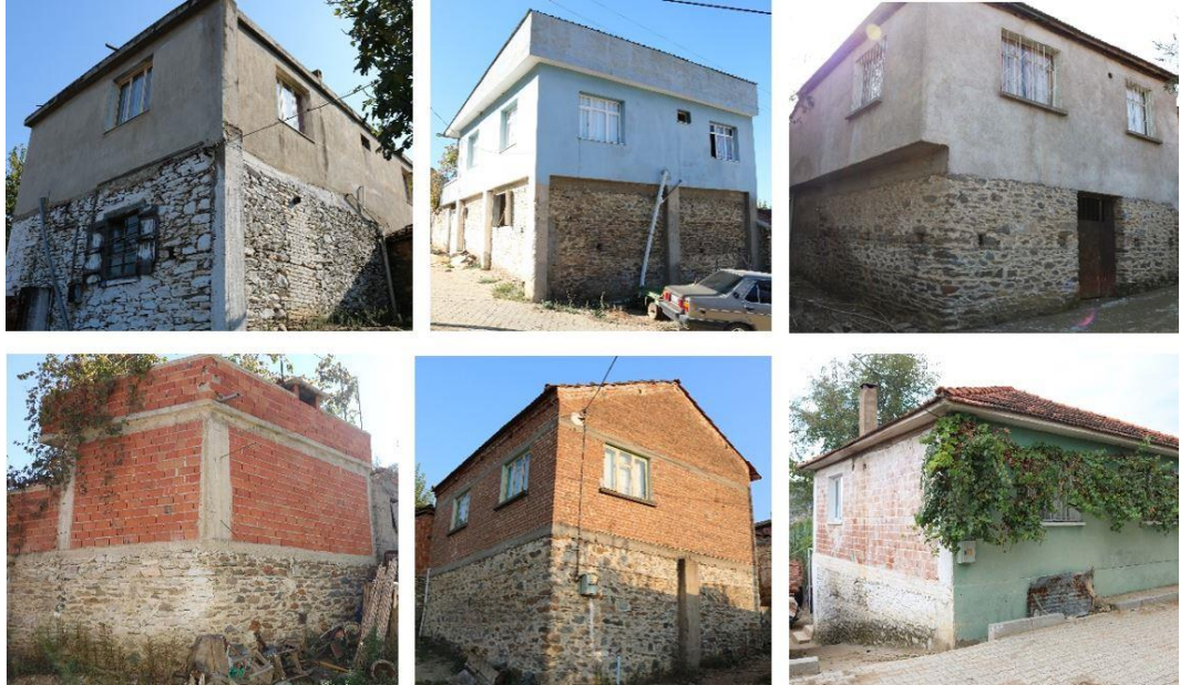
Şekil 4.74 Peşrefli köyünde geleneksel yapım sistemi ve malzemeye aykırı yeni kat inşası örnekleri (Kişisel arşiv, 2018)
