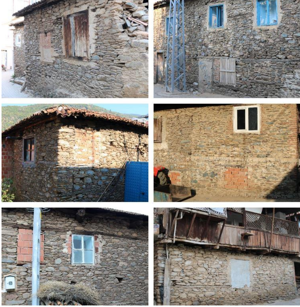
Şekil 5.58 Eğridere köyünde kapı ve pencere açıklıkları kapatılan yapı örnekleri (Kişisel arşiv, 2018)
