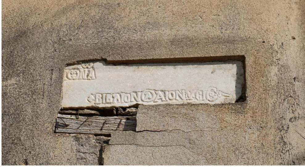
Şekil 4.7 214 ada 7 parselde bulunan yapının duvarındaki devşirme malzemeler (Kişisel arşiv, 2018)
