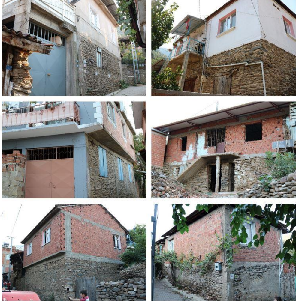
Şekil 5.56 Eğridere köyünde geleneksel yapıya aykırı yeni kat inşası örnekleri (Kişisel arşiv, 2018)
