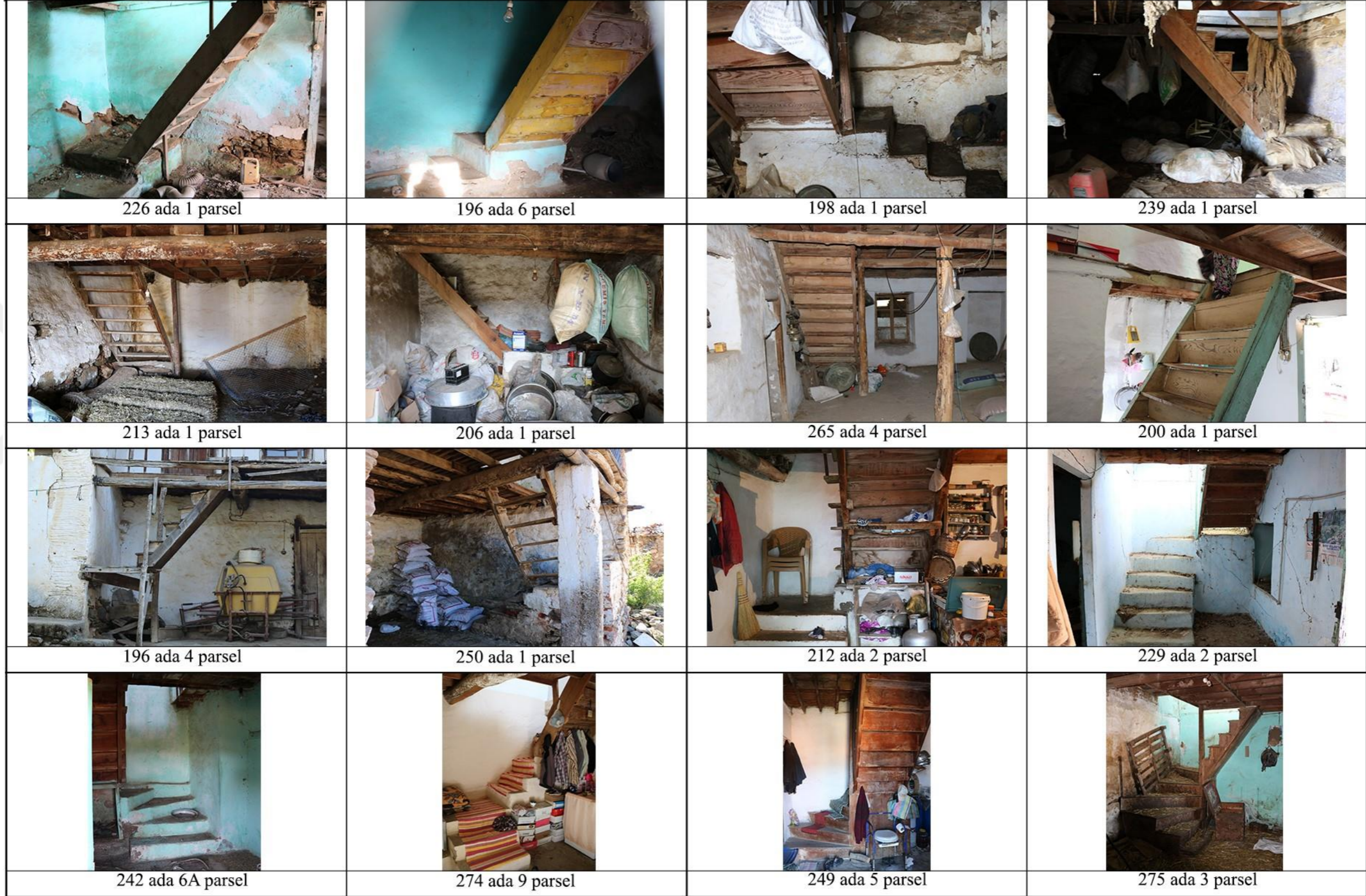
Şekil 4.59 Peşrefli köyü geleneksel konutlarında bulunan merdiven örnekleri (Kişisel arşiv, 2019)
